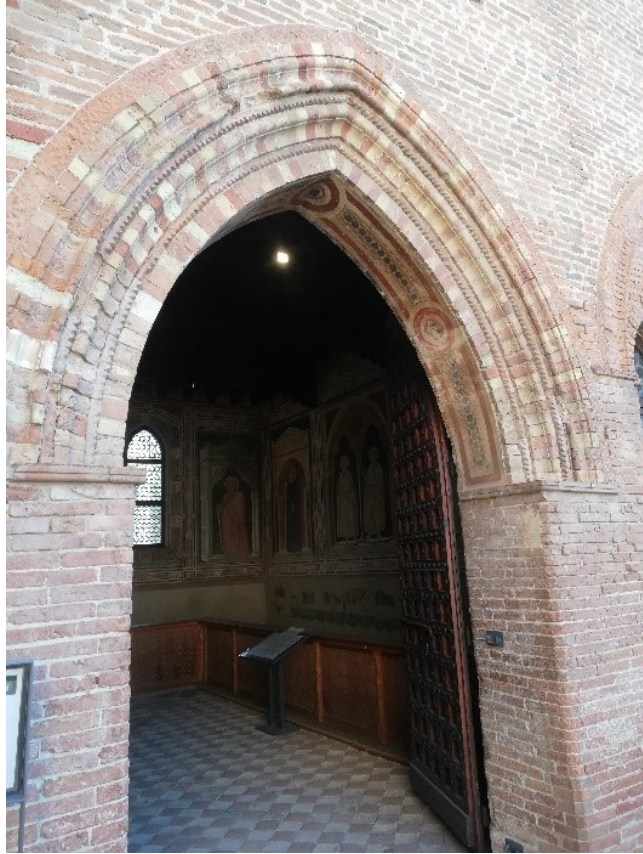
Fig. 6 - AULA CAPITOLARE – PORTALE DI ACCESSO
