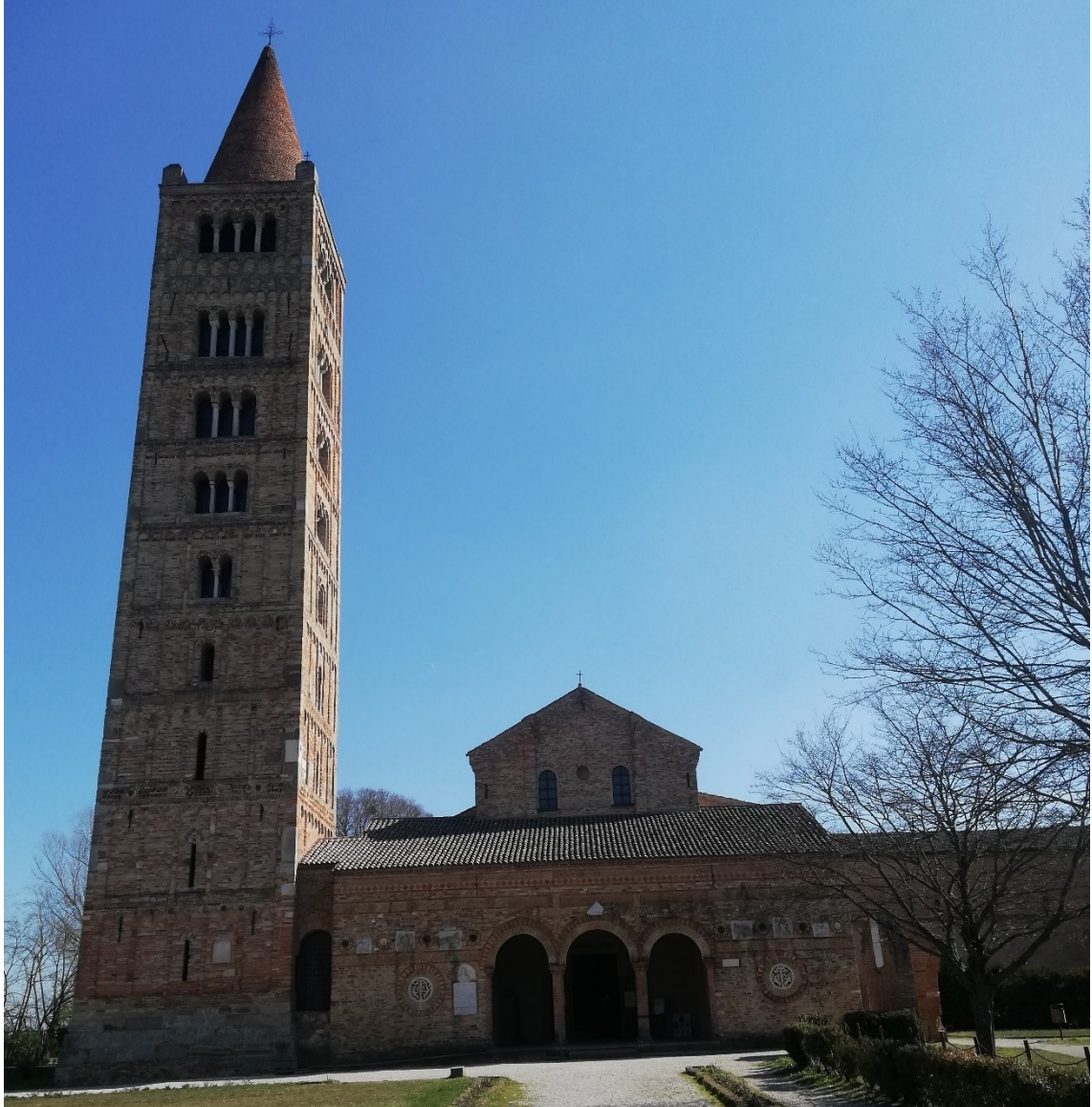
Fig. 2 – ABBAZIA DI POMPOSA: VISTA FRONTALE CON ATRIO E CAMPANILE
