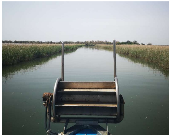
Figura 1-5: Esempio di canale principale proseguimento del Fiume Stella.
