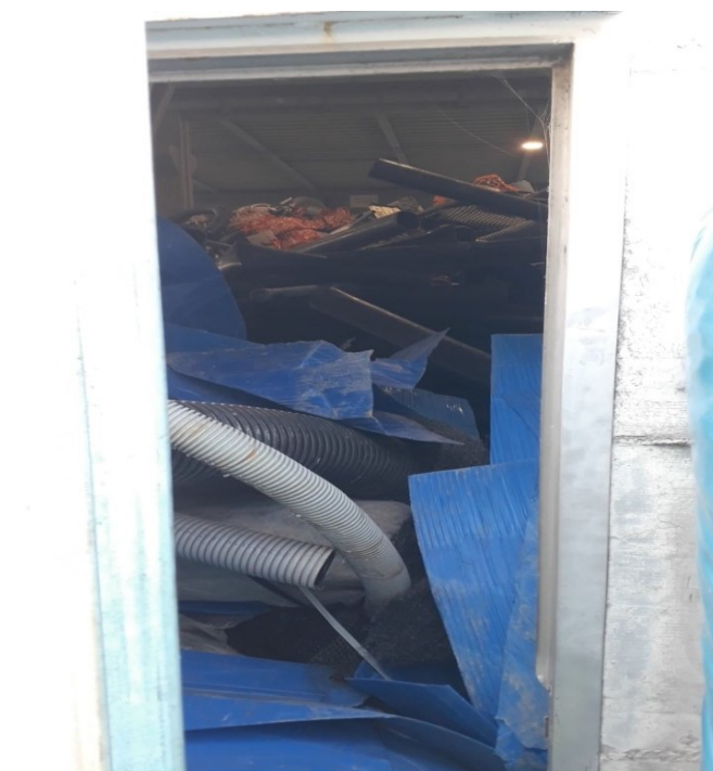
Figura 4.9 Foto scattata durante un sopralluogo che mostra una delle vie d'esodo ostruite dai rifiuti
