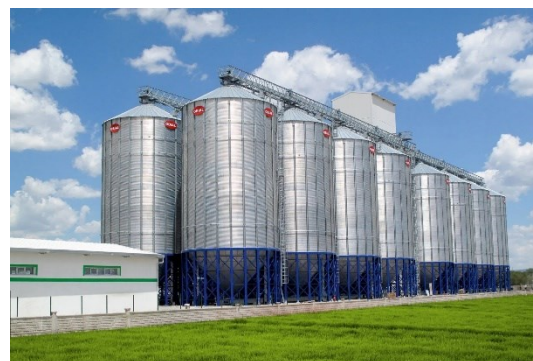
Figura. 1.2 Silos in acciaio
