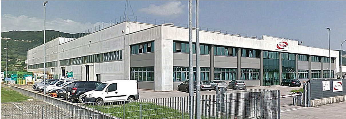
Figura 1.4.7.1: Vista esterna dello stabilimento, si distinguono in altezza uffici, produzione e magazzino.
