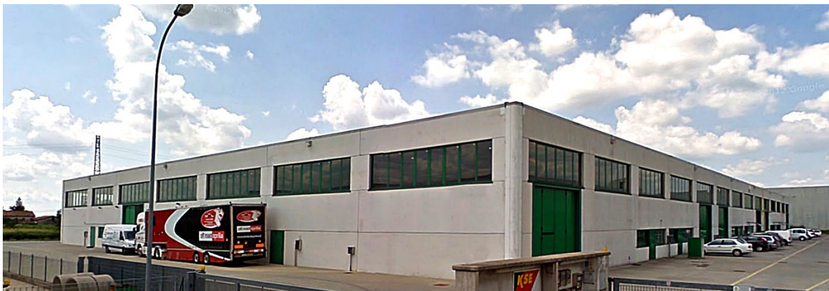
Figura 1.4.10.1: Vista esterna dello stabilimento KSE, in facciata pannelli di chiusura orizzontali e aperture.
