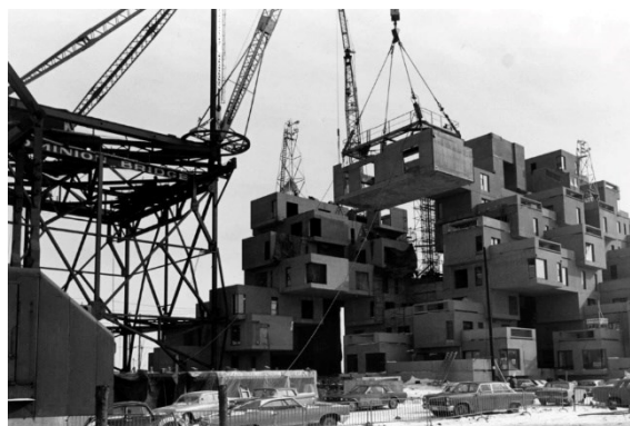
Figura 2.1.4: Sistema costruttivo adattivo dell'Habitat 67, Moshe Safdie, Montreal, Canada, 1967.
