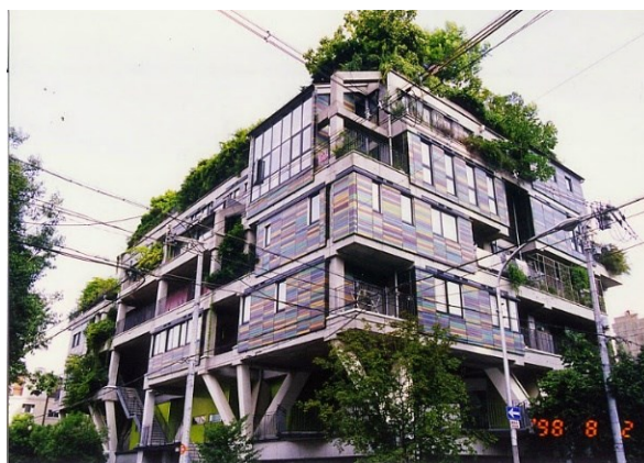
Figura 2.1.3: Esempio di struttura open building system, Next 21, Yositika Utida, Shu-Koh-Sha Architectural and Urban Design Studio, Osaka, Giappone, 1994.
