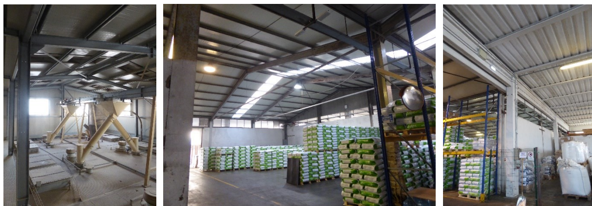
Figura 1.4.14.3: A sinistra, vista della cima della nuova torre, a pavimento gli imbocchi sommitali dei silos.
