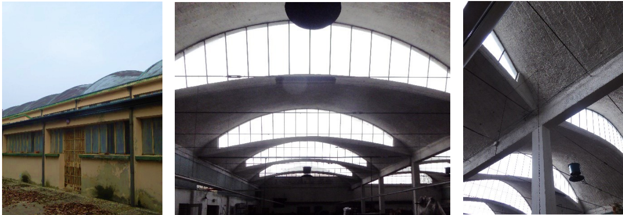
Figura 1.4.8.1: A sinistra, vista esterna dello stabilimento sul lato degli spogliatoi.
