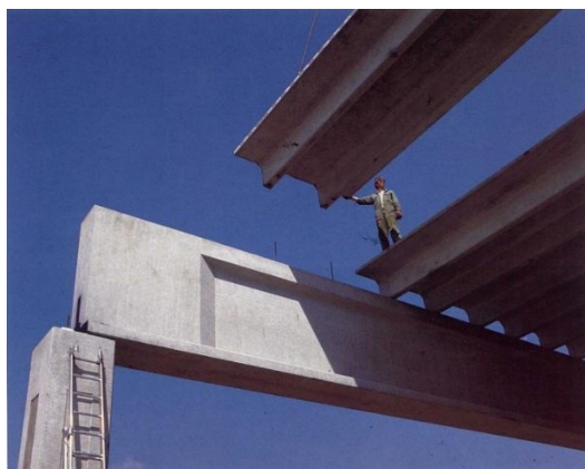
Figura 1.3.1.2: A sinistra, posa di un sistema di copertura con tegoli a pi-greca.
