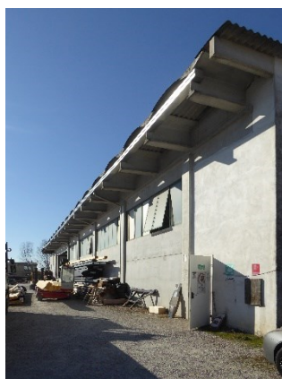
Figura 1.4.5.1: A sinistra, pilastro a forcella con mensola sporgente, incastro con trave principale a T.
