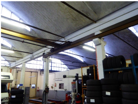
Figura 1.4.9.1: A sinistra, foto interna sull'infilata di pilastri tra le due campate e sulla copertura a shed curvi.
