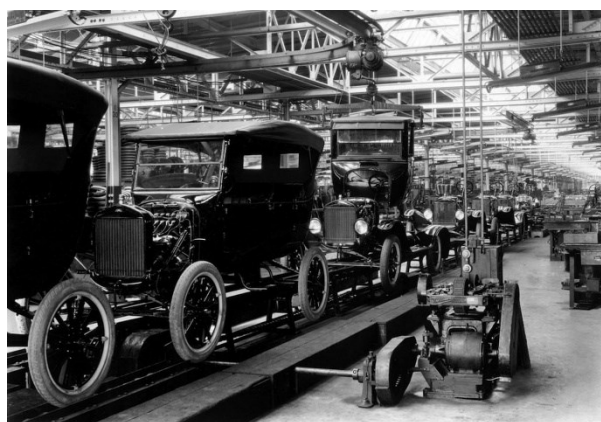
Figura 1.1.2.1: Produzione automobilistica in serie nello stabilimento Ford Motor Company, Michigan, 1903.
