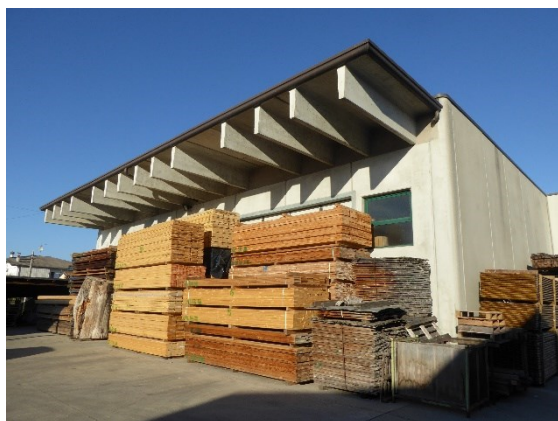
Figura 1.4.4.1: A sinistra, sistema strutturale con pilastri a forcella e tegoli Pi-greco a vista di copertura.
