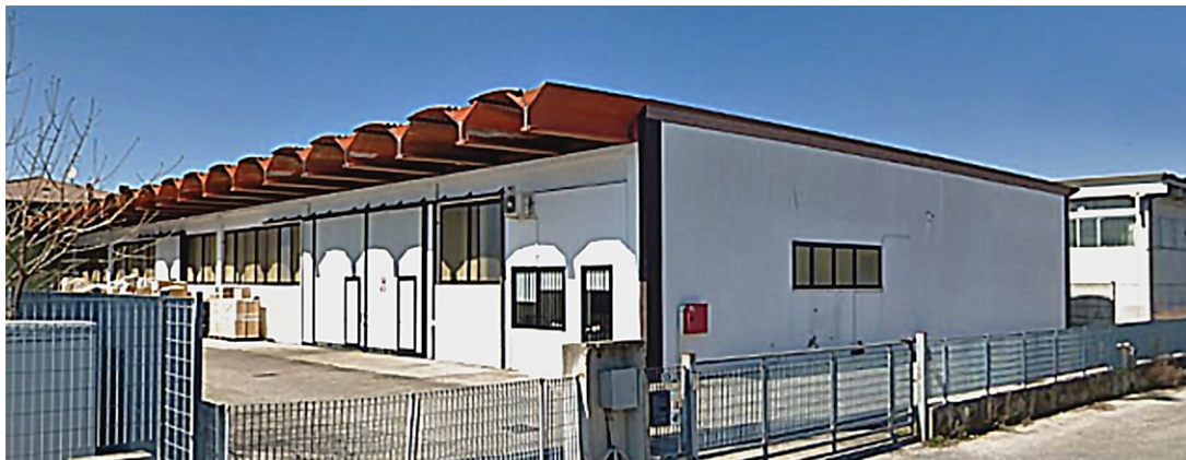
Figura 1.4.6.1: Vista esterna dello stabilimento, in evidenza l'aggetto di copertura con travi ad Y metalliche.
