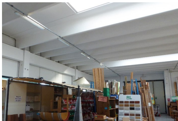
Figura 1.4.4.1: A sinistra, sistema strutturale con pilastri a forcella e tegoli Pi-greco a vista di copertura.
