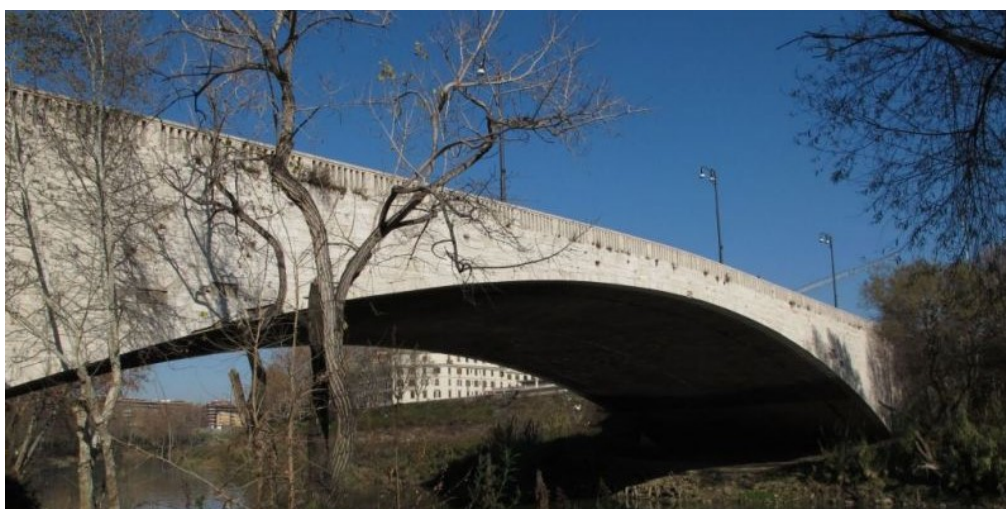
Figura 8.19: Ponte Testaccio a Roma prima "Ponte d' Africa"
