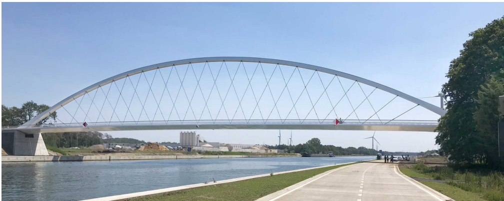
Figura 8.13: Ponte di tipo network , Tessengerlo, Paesi Bassi
