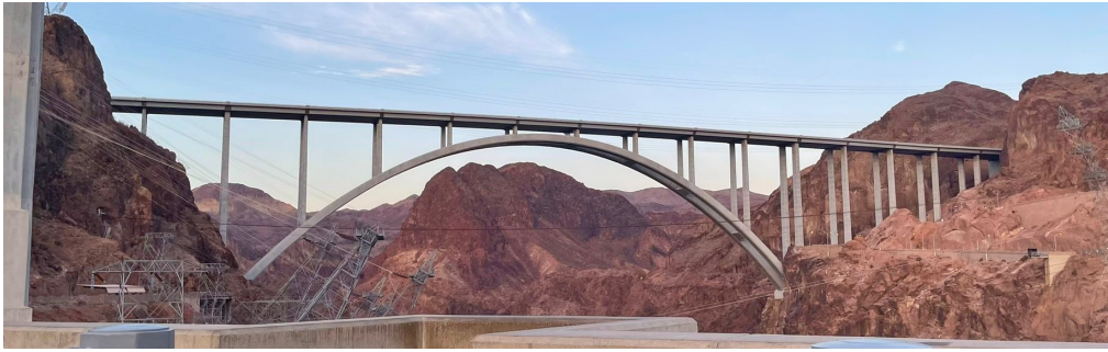
Figura 1.7: Mike O'Callaghan - Pat Tillman Memorial Bridge; Clark County, Nevada - Mohave County, Arizona USA, 2005-2010. Il ponte in calcestruzzo, supera il fiume Colorado di fronte all Diga Hoover, è stato costruito con la tecnica degli sbalzi successivi con tiranti provvisori
