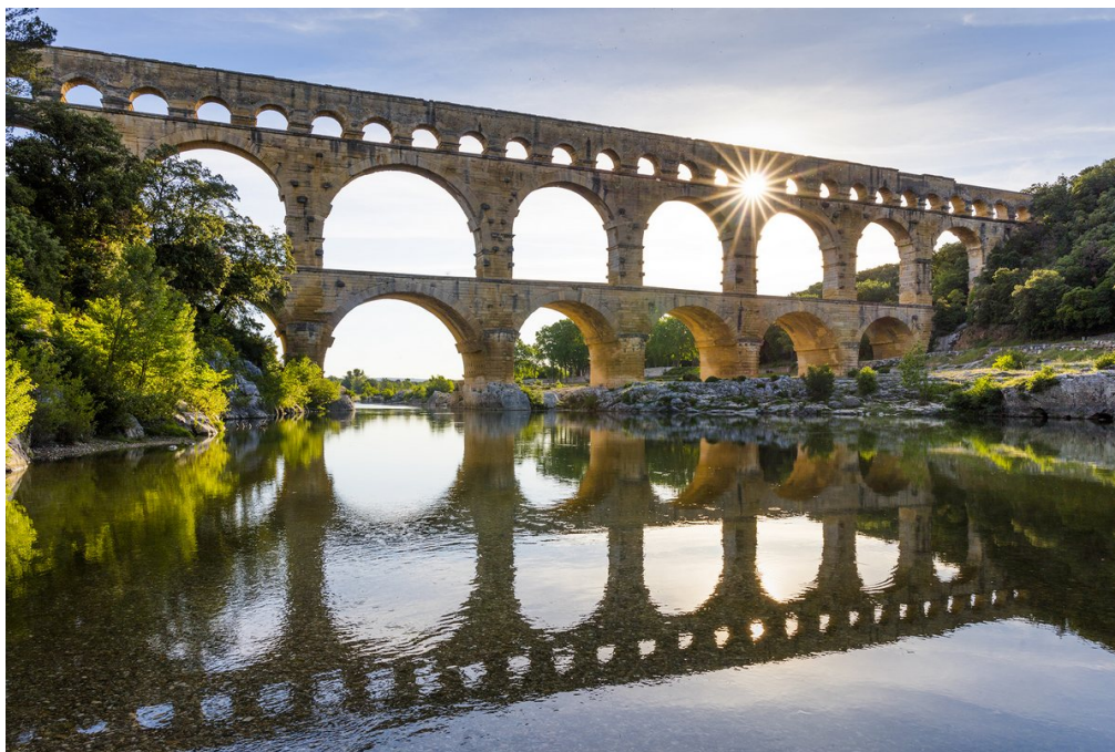
Figura 1.2: Pont du Gard, acquedotto romano formato da tre ordini di archi, lungo 275 metri e alto 49. Remoulins, Francia 19 a.C.
