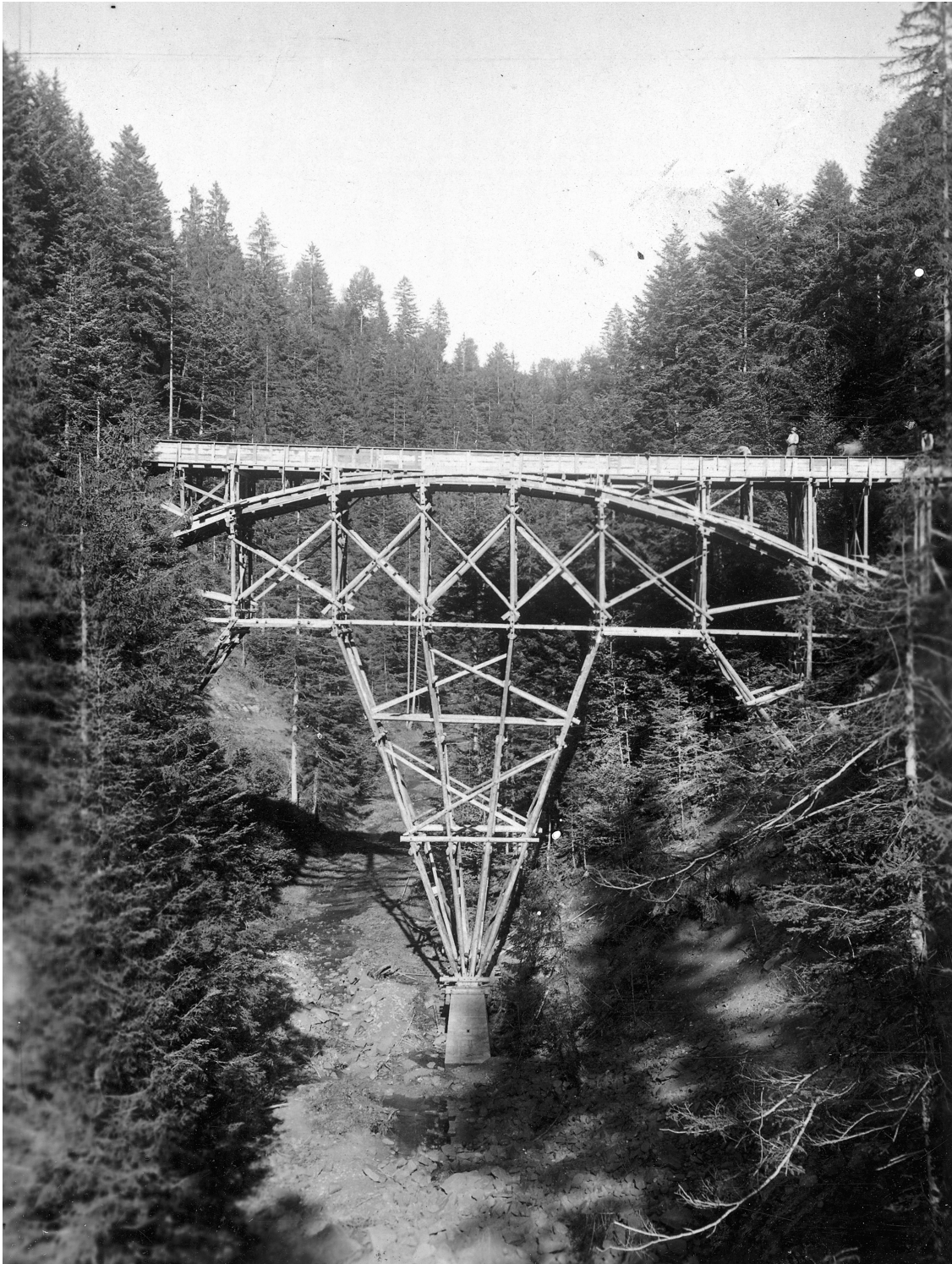
Figura 8.26: Veduta della centina lignea del ponte Schwandbachbrücke
