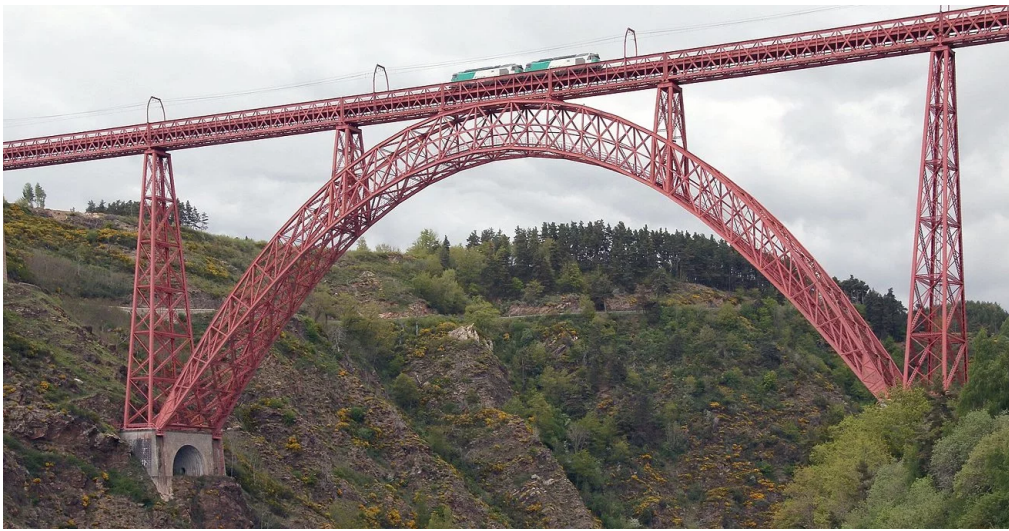
Figura 1.6: Viadotto Garabit; vallata del Truyère, Ruynes-en-Margeride, Francia, 1880-1884. Il viadotto, progettato da Eiffel si presenta come un arco reticolare metallico con schema statico a due cerniere
