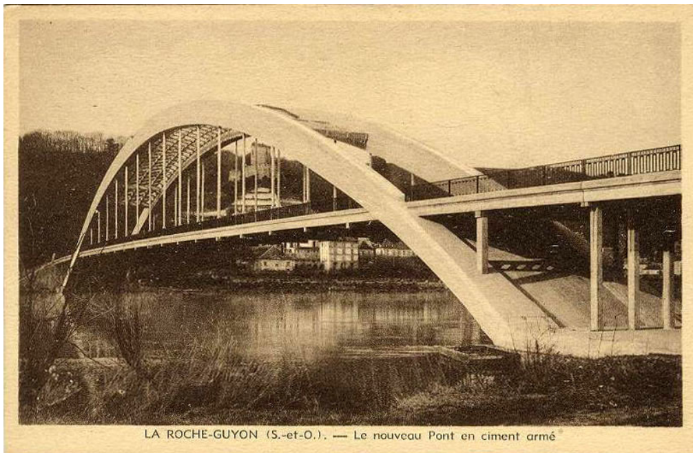
Figura 8.20: Ponte di La Roche Guyon nel 1934 poco dopo l'inaugurazione; si nota come le sezioni dell'arco varino dalla chiave alle imposte
