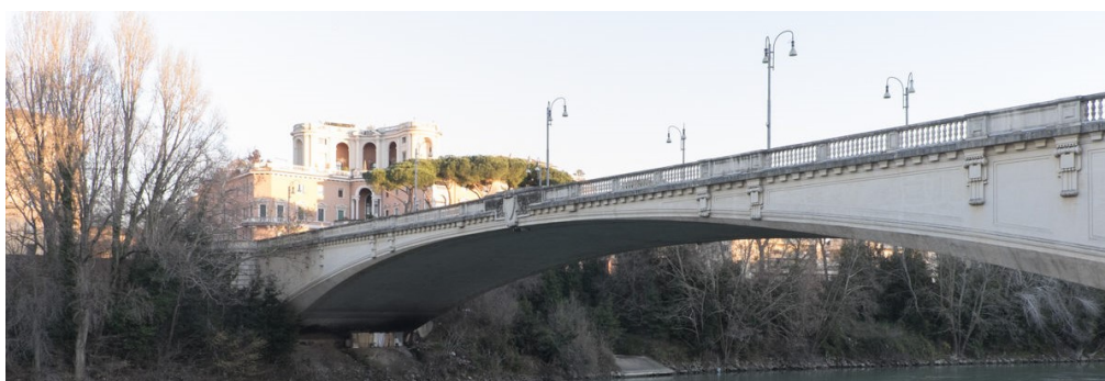
Figura 8.17: Ponte del Risorgimento a Roma visto dal lungo Tevere
