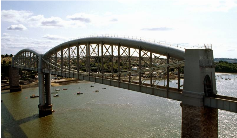
Figura 8.9: Ponte Royal Albert, è visibile nella pila il nome di Isambard Kingdom Brunel e l'anno di costruzione, si notano inoltre la sezione circolare del corrente compresso superiore, il corrente teso formato da catene e la struttura di connessione reticolare
