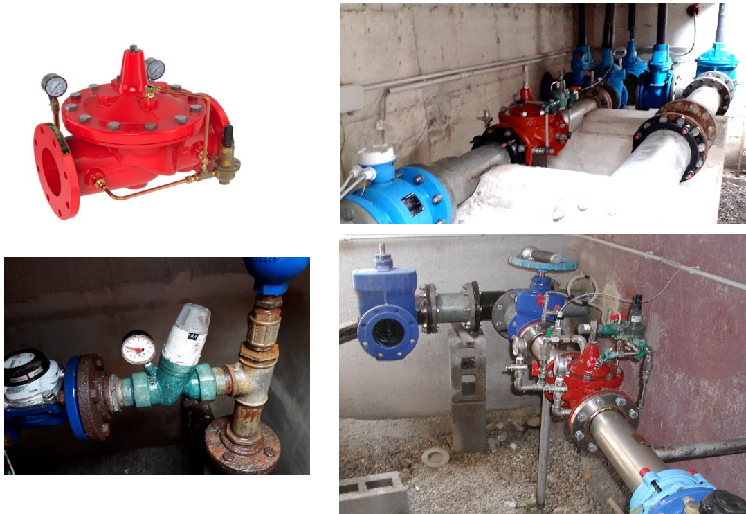
Figura 1.35: Esempio di valvole regolatrici di pressione nei punti di consegna.
