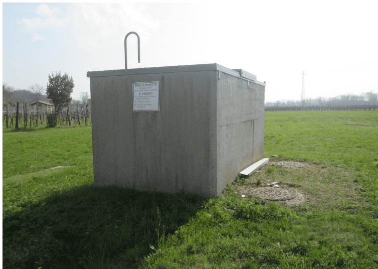
Figura 1.17: Foto esterna di una parte della struttura del campo pozzi Settolo.
