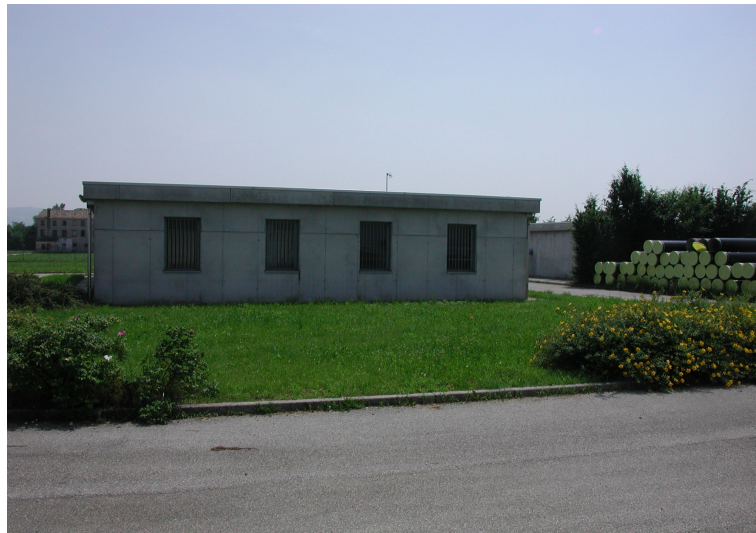
Figura 1.21: Foto esterna di una parte della struttura del campo pozzi Moriago.
