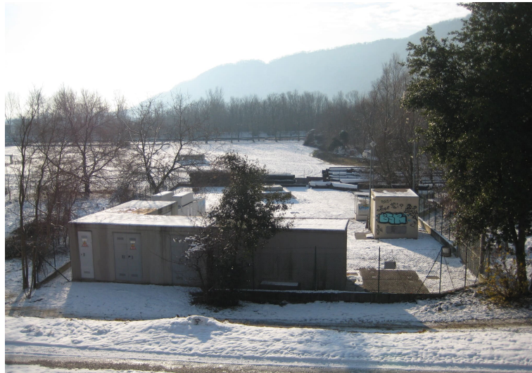
Figura 1.23: Foto esterna di una parte della struttura del campo pozzi Fener.
