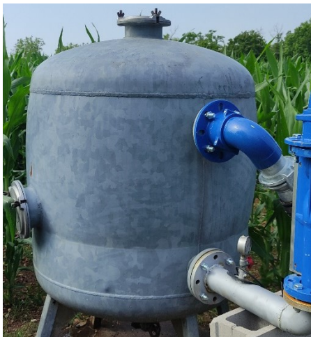
Figura 3.4: Filtro a letto filtrante dell'azienda (2)
