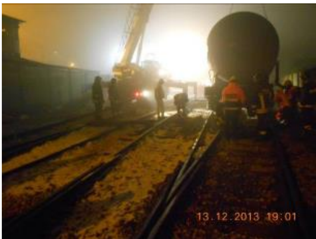
Fig.2.3: Posizionamento del materiale oleoassorbente lungo la massciata ferroviaria.
