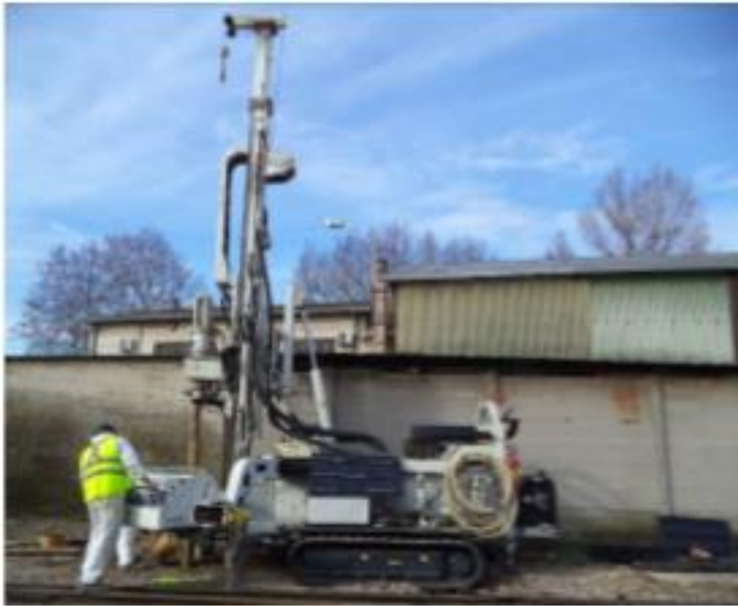
Fig.3.9:Realizzazione dei sondaggi tramite la sonda Fraste Multidrill XL.
