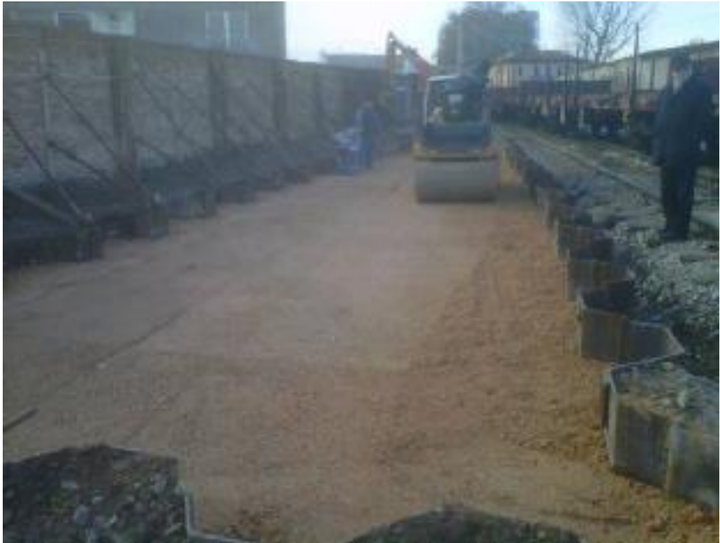
Fig.3.8: Operazioni di compattazione del terreno.
