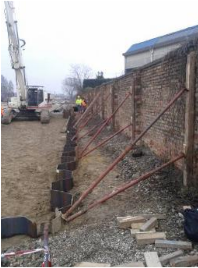
Fig.3.4: Puntellamento del muro.
