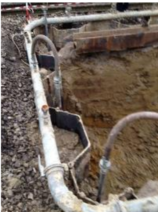
Fig.3.5: In questa figura si possono vedere i well-points collegati al tubo collettore mediante il manicotto flessibile.
