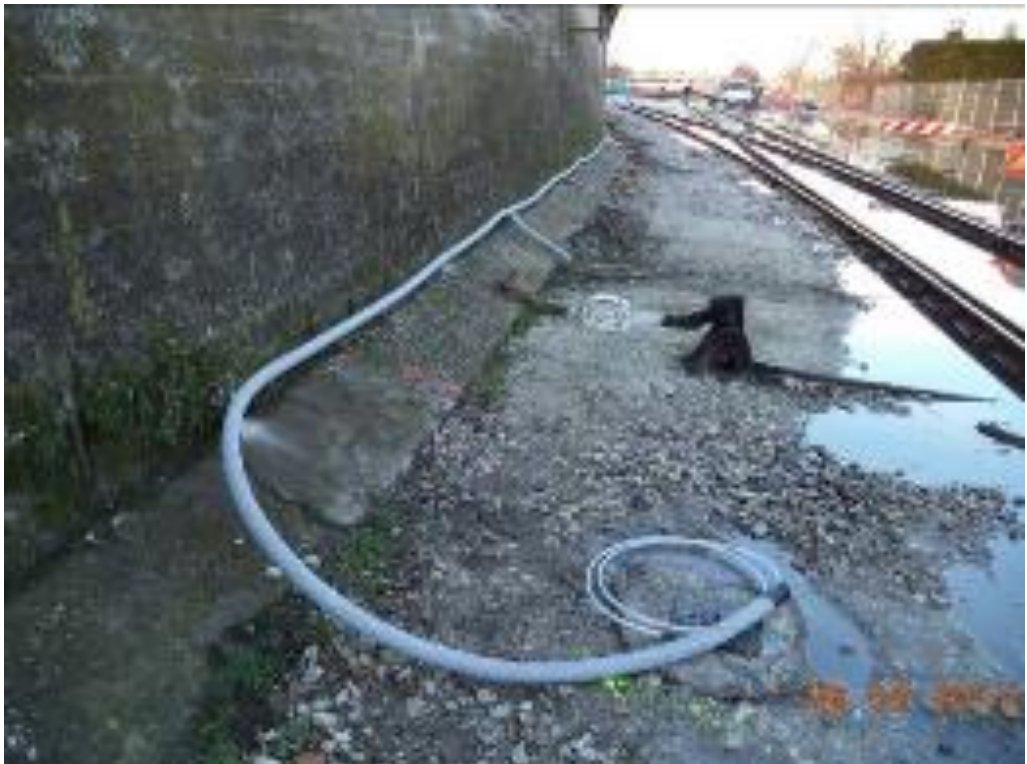
Fig.3.16: Posizionamento delle condotte di aspirazione.
