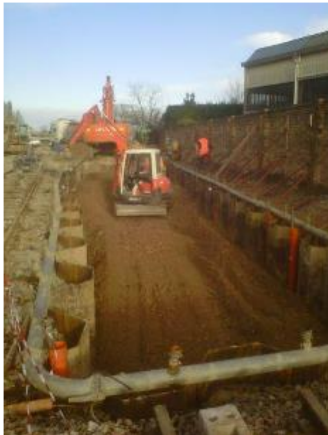
Fig.3.7: Operazioni di ripristino dell'area
