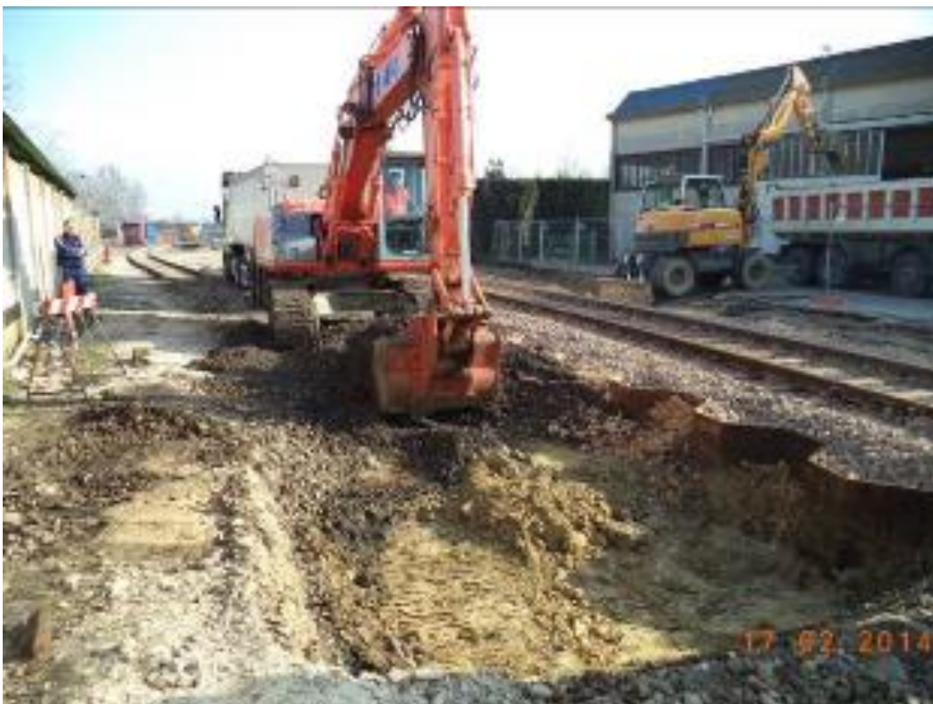
Fig.3.12: Operazioni di scavo.
