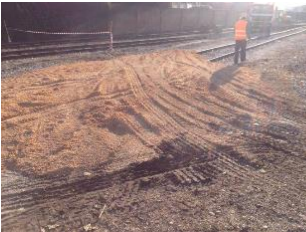
Fig.3.2: Condizione del sito prima dell'inizio dei lavori.
