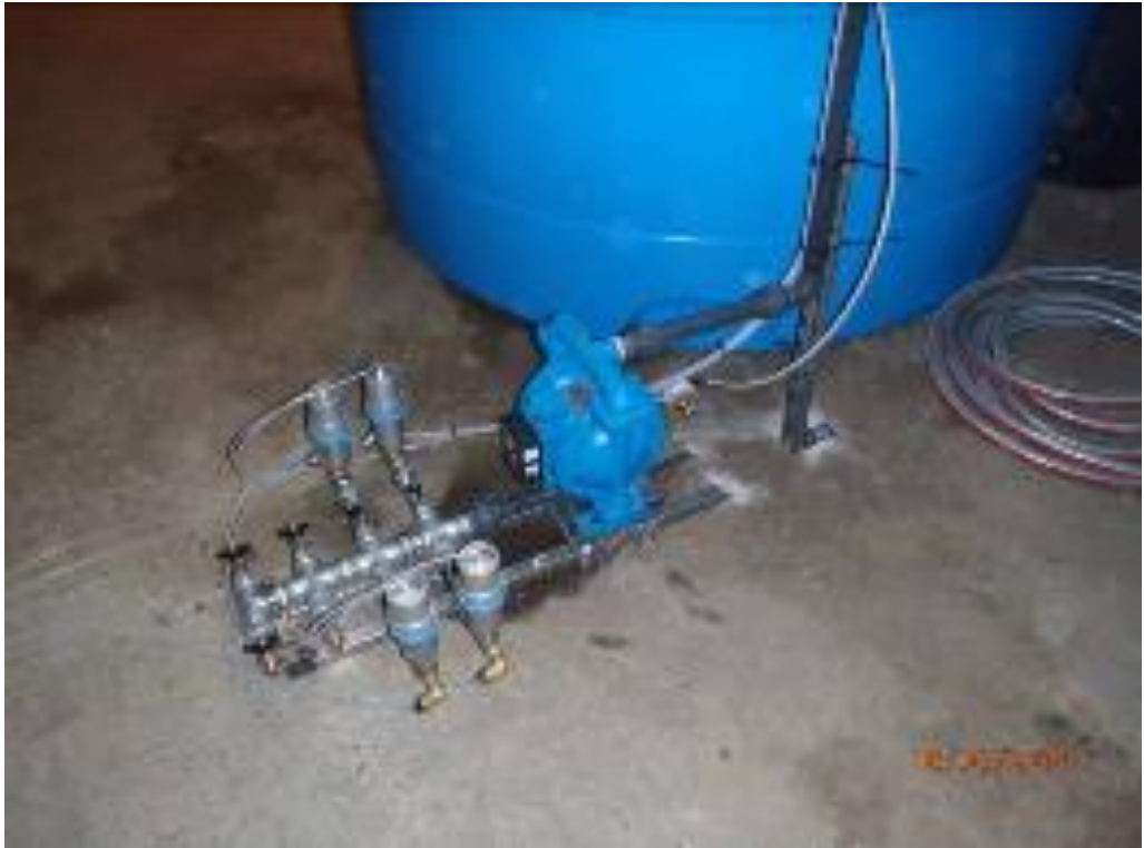
Fig.3.15: Pompa di aspirazione di tipo pneumatico.
