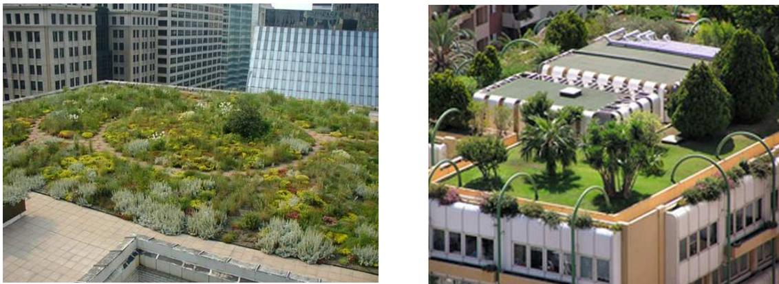
**Figura 3.5.** Le tipologie di green roofs: estensivo (sinistra) ed intensivo (destra)
