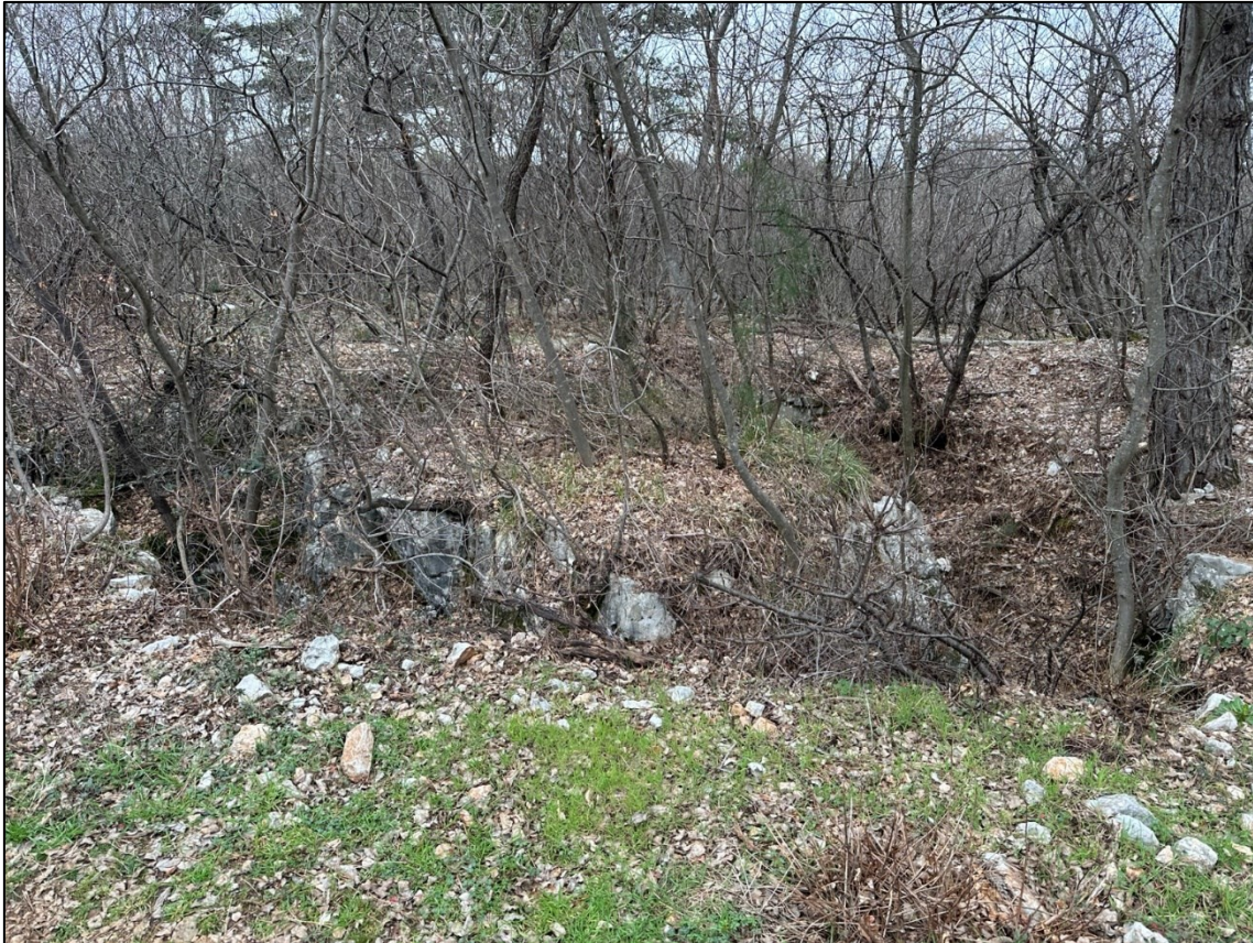
Figura 5.3: Tratto di trincea nell'area del Castellazzo di Doberdò caratterizzata da una doppia direzione.
