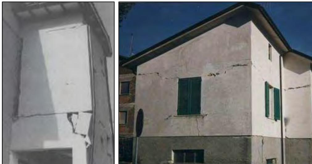
Figura 6-10: Esempi di rottura per scorrimento
