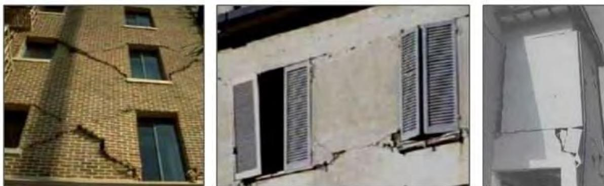
*Figura 1-4: Esempi di rottura per fessurazione diagonale, flessione, scorrimento*
