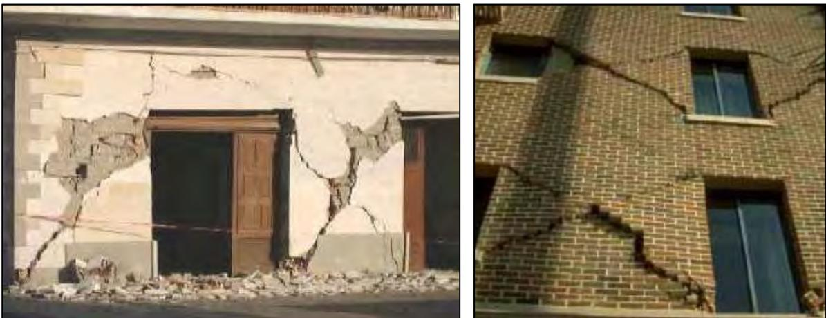
Figura 6-8: Esempi di rottura per fessurazione diagonale
