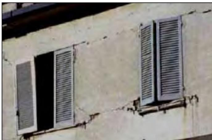
Figura 6-6: Esempio di rottura per pressoflessione/ribaltamento
