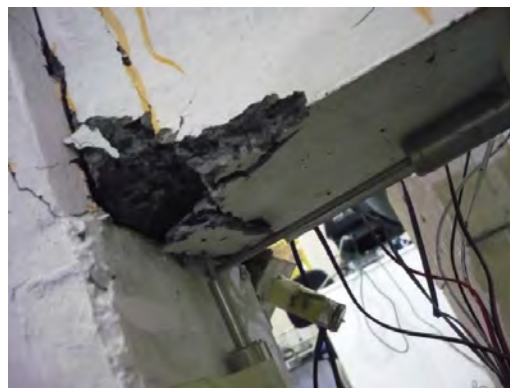
Figura 3.32 Particolare del danneggiamento dell'unione dopo l'esecuzione della prova.
