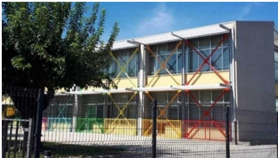
Rinforzo mediante gridshell (Sergio Fantinato, 2016)
