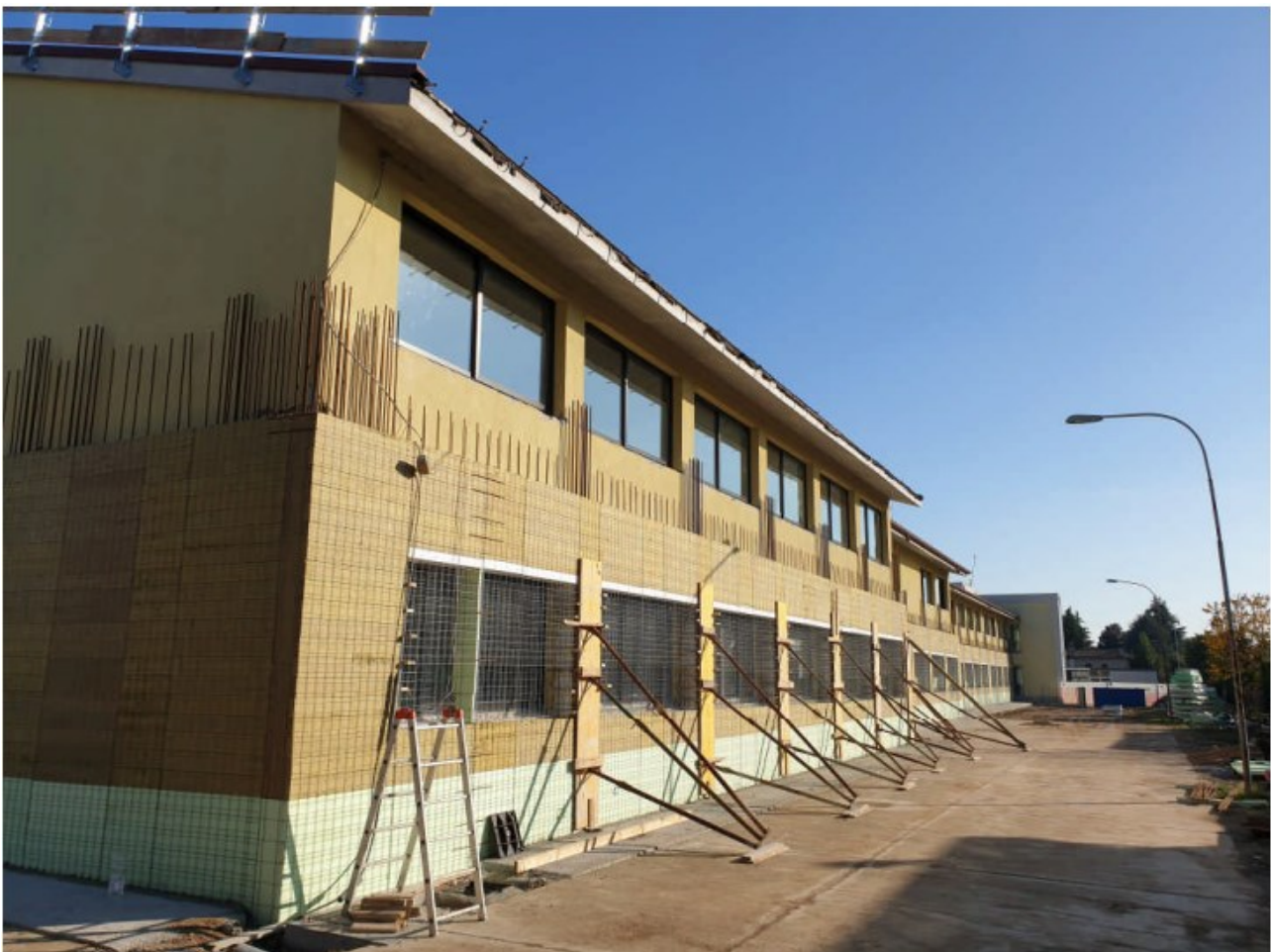
Rinforzo mediante cappotto sismico (Scotta et al., 2021)
