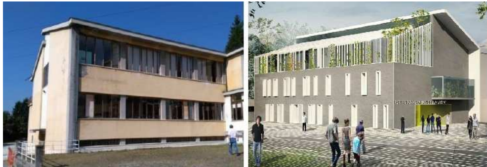
Figura 2.2: Edificio pre (sinistra) e post (destra) intervento
