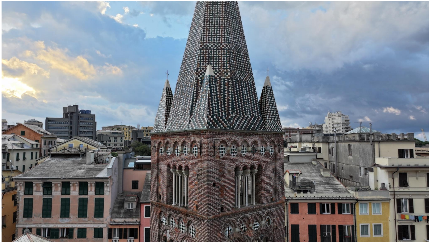
Particolare della parte superiore del campanile di S. Agostino dal lato Sud-Ovest
