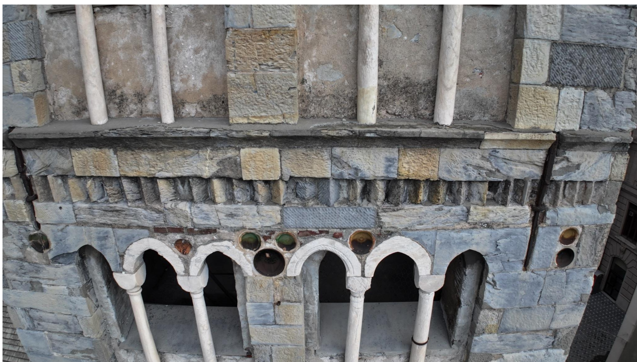
Dettaglio dei bacini ceramici immurati nel campanile di S. Giovanni di Prè
