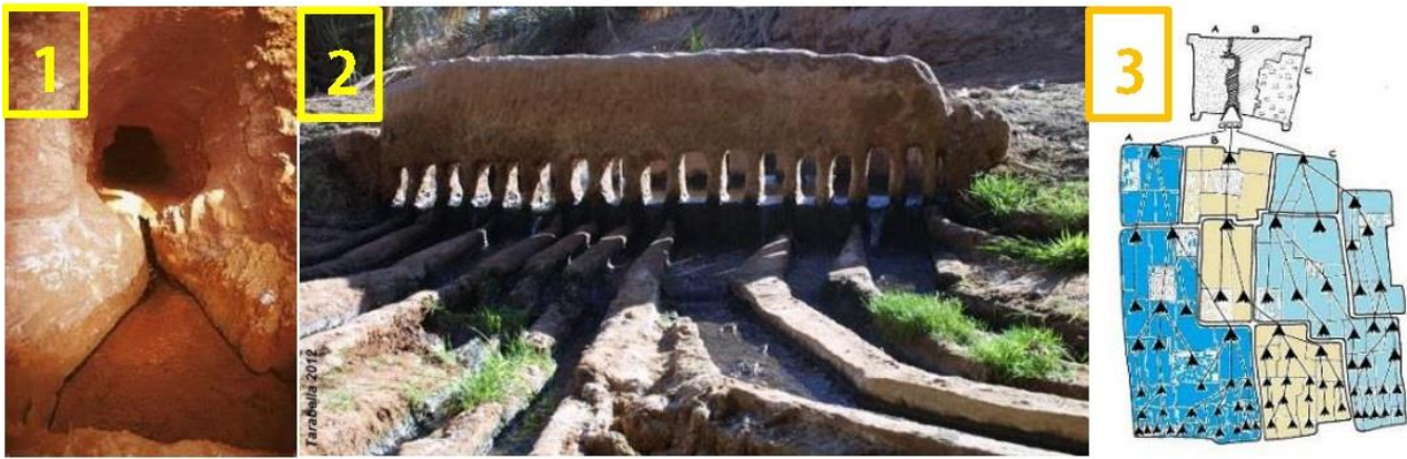
Figura 5.3 – Lo sbocco dell’acqua dalla foggara (1) Il pettine ripartitore “kesria” (2) e lo schema di distribuzione delle quote (3) (foto da www.pangea-project.org )
