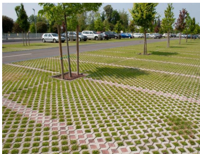
Figura 4.13 – Pavimentazioni drenanti (foto da www.ferraribk.it )
