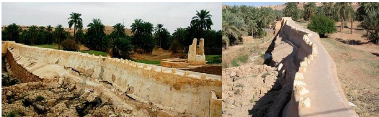
Figura 3.25 – Diga seminterrata di Beni Isguen (Algeria) (foto da www.pangea-project.org )
