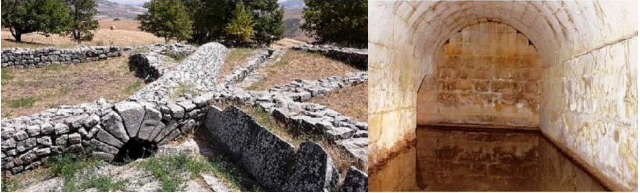
Figura 3.13 – Canalizzazione voltata, Rossano del Vaglio (Potenza; foto a sinistra) e interno con volta a botte di un canale voltato, Gravina (Puglia; foto a destra) (foto da www.pangea-project.org )
