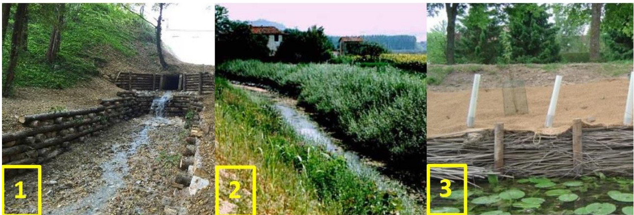
Figura 4.10 – Alcuni interventi di ingegneria naturalistica: palificata doppia viva (1) (foto da www.cbc-costruzioni.it ), copertura diffusa (2) (foto da www.irisambiente.it ), viminata (3) (foto da www.nwrm.eu )
