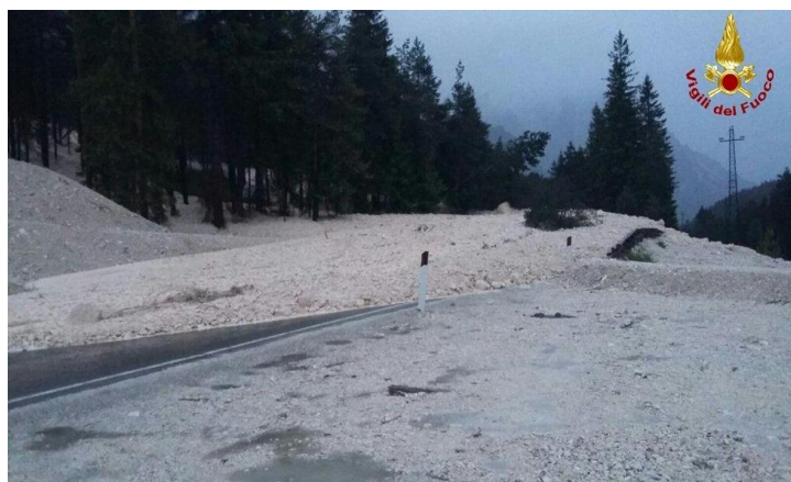
Figura 5.6: La colata di detriti del 15 giugno 2016 (Immagine Vigili del Fuoco).
