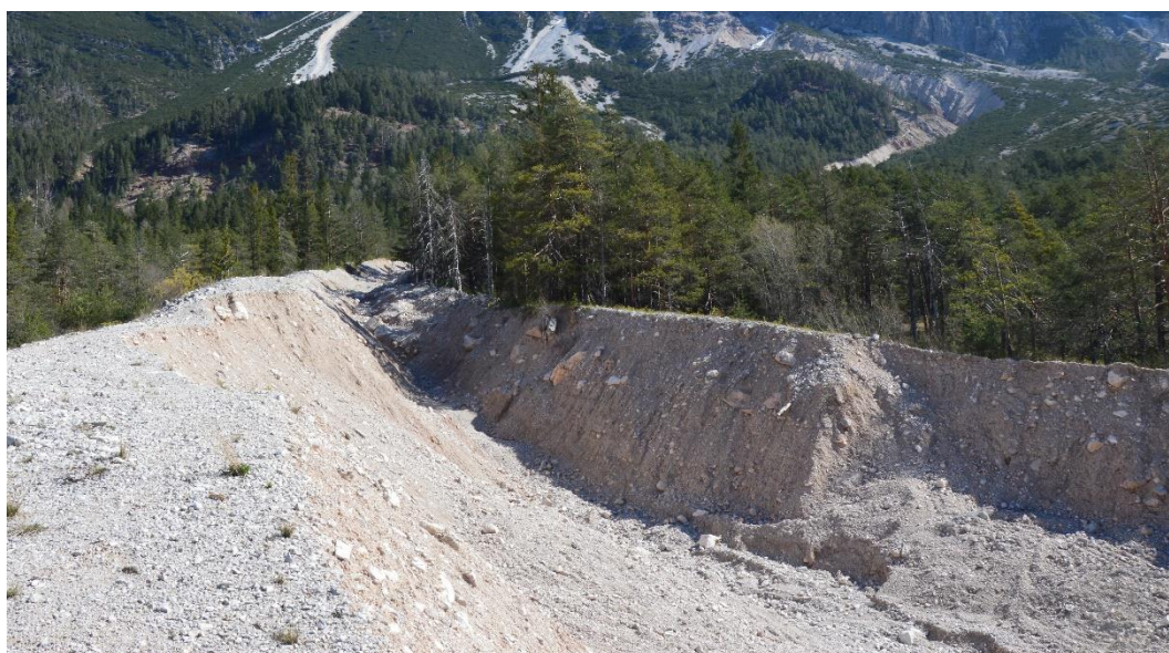
Figura 2.8: Gli argini artificiali costruiti nell'ultimo tratto del canale.
