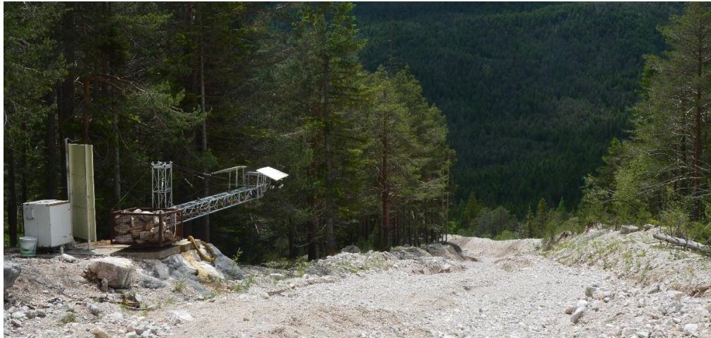
Figura 4.3: La stazione di valle montata e in posizione.
