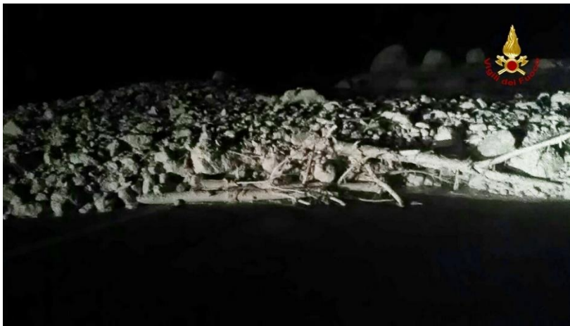
Figura 5.9: La colata di detriti del 4 agosto 2016 che ha raggiunto la Statale Alemagna (Immagine Vigili del Fuoco).
