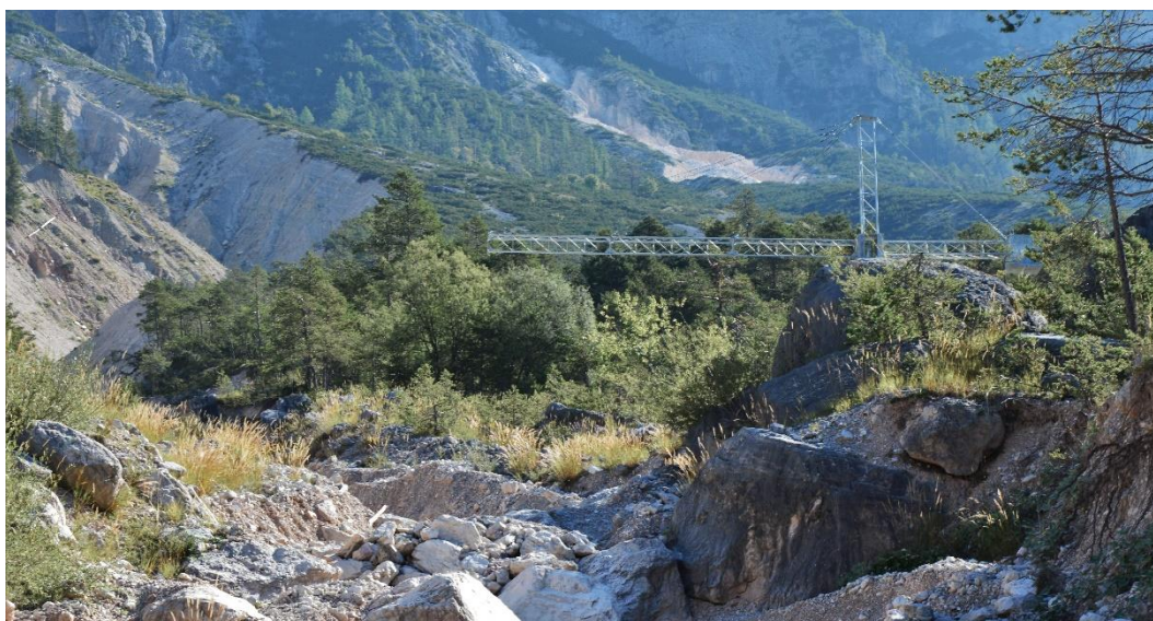
Figura 4.5: La struttura della stazione intermedia in posizione.
