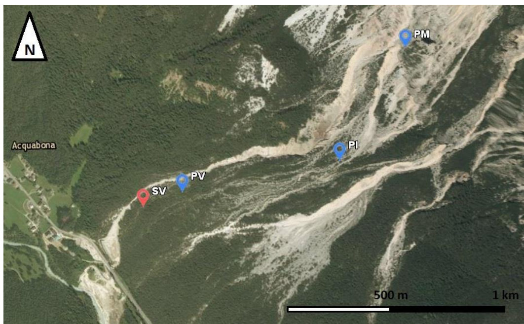
Figura 3.1: Le posizioni degli elementi del sistema di monitoraggio all'interno del sito del Rio Acquabona. SV indica la stazione di valle, PV il pluviometro di valle, PI il pluviometro intermedio e PM il pluviometro di monte (immagine LANDSAT).
