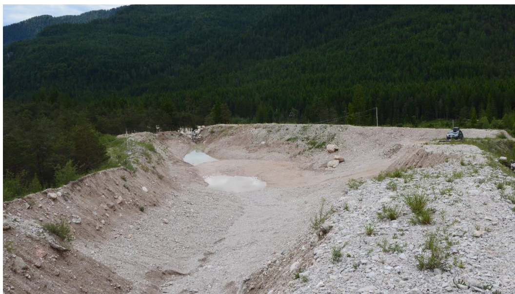
Figura 2.7: Il bacino di accumulo dei sedimenti posto subito a monte della Strada Statale 51 Alemagna.
