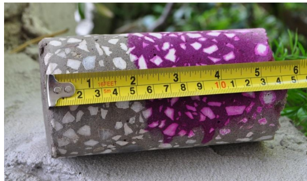
Figura 5.1- Misurazione della profondità di carbonatazione su carota di calcestruzzo
