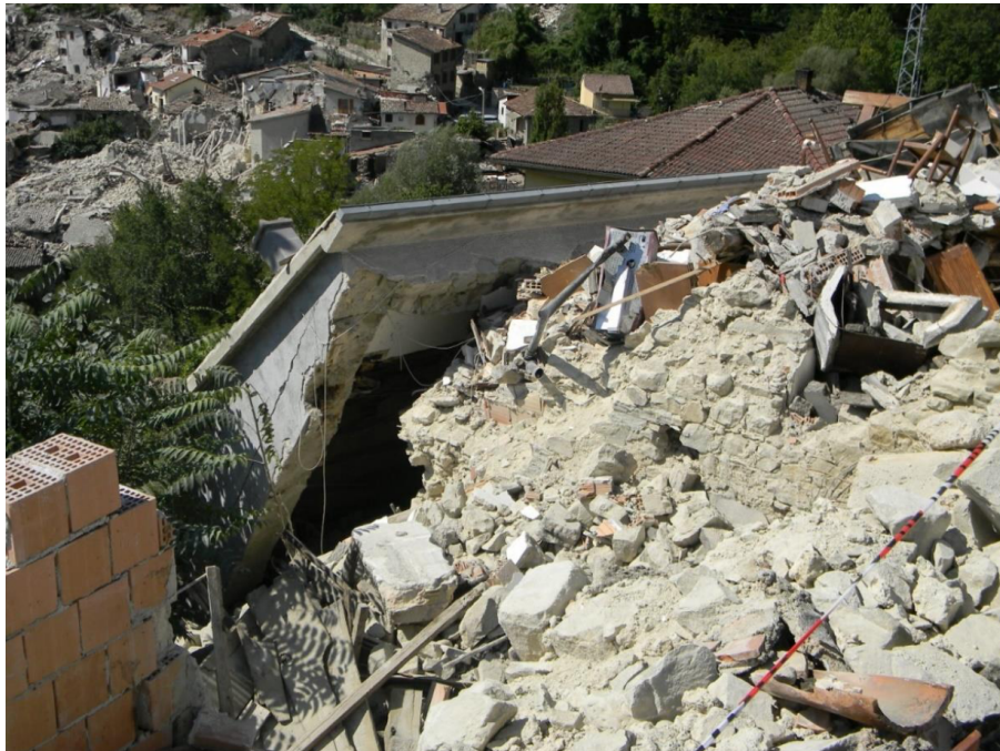
Figura 1.1: Collasso di un edificio costruito con muratura in sasso e copertura in calcestruzzo armato [12].
