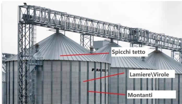
Fig. 1.8.1: Componenti principali dei Silos.
