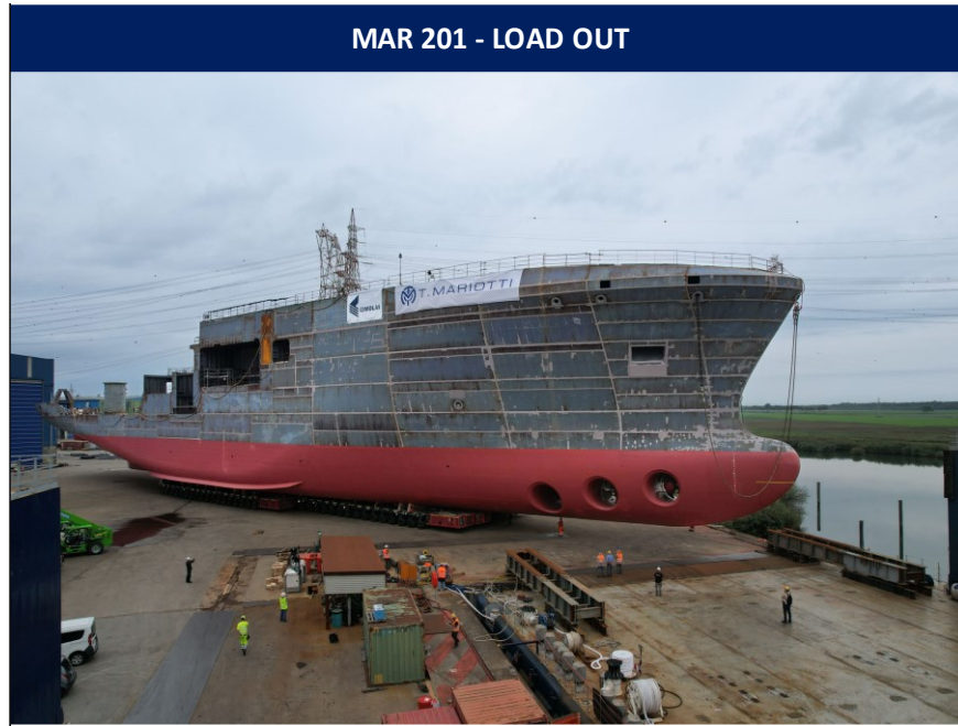
Figura 5.44 - Scafo della MAR201 durante la fase di "load-out"
