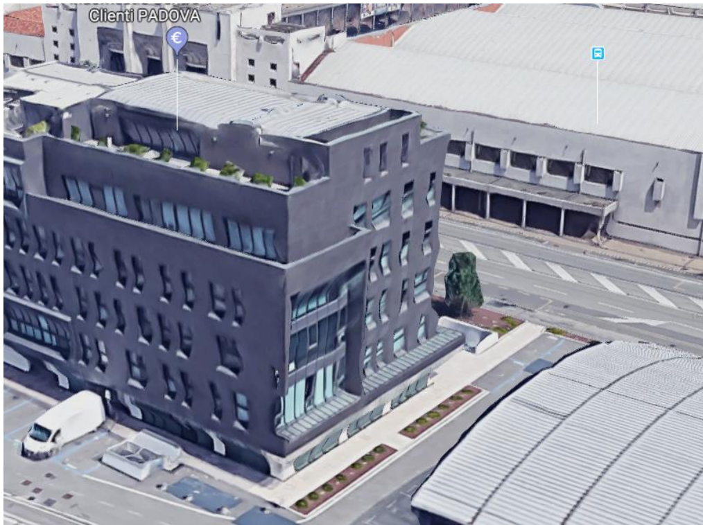
Figura 2.3: immagine, tratta da Google Maps, dell'edificio davanti al padiglione 1.
