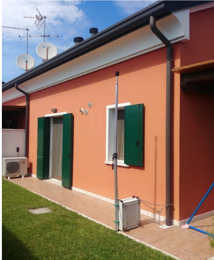
Figura 4 - Esempio di installazione del fonometro sulla facciata del ricettore
