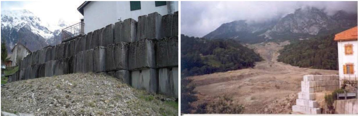
FIGURA 2.13 : Muro in blocchi in calcestruzzo eretto in prossimità dell'abitato di Funes nel 1992
