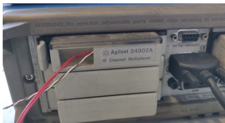
Figura 2.18 – Centralina di acquisizione della temperatura tramite termocoppia.
