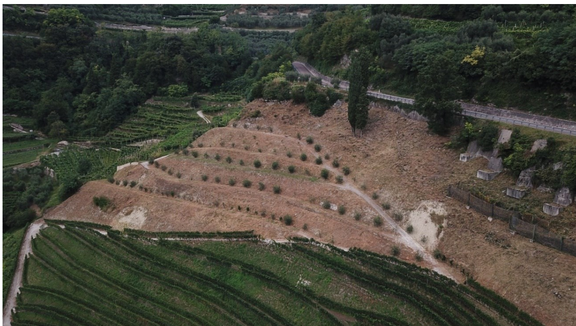
Figura 2.4 Veduta aerea della parte superiore dell'area di studio, soggetta all'attivazione di frane superficiali (foto di Luca Mauri)
