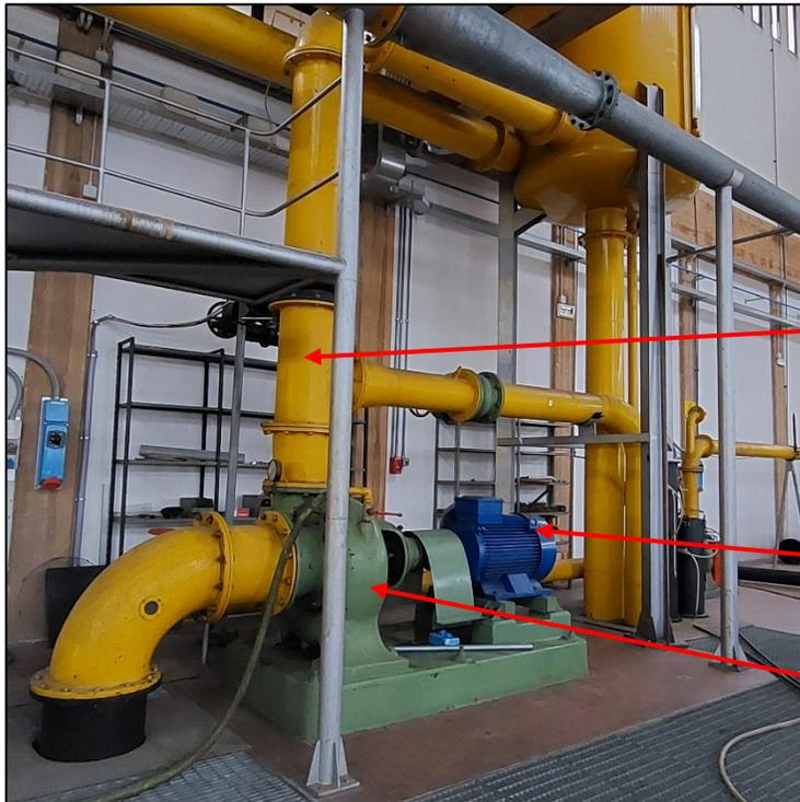
**Il sistema composto da pompa di alimento serbatoio e dal suo motore elettrico.**
