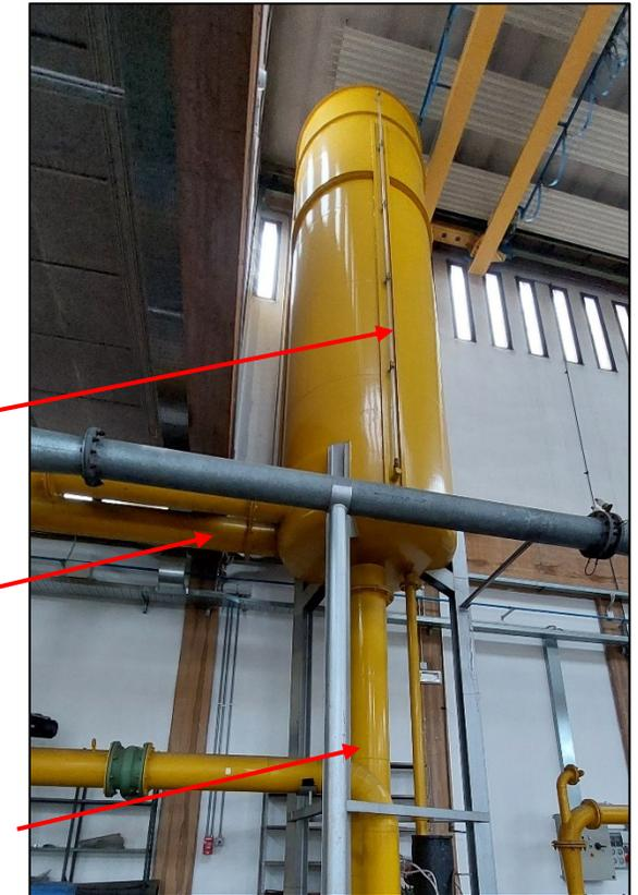
La condotta proveniente dal serbatoio si sdoppia in corrispondenza di due valvole a saracinesca, con la possibilità di alimentare due tipi diversi di turbine:
