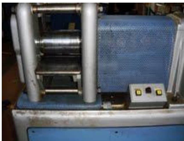
Figura 2.2: Particolare dell'equipaggiamento elettrico del laminatoio
