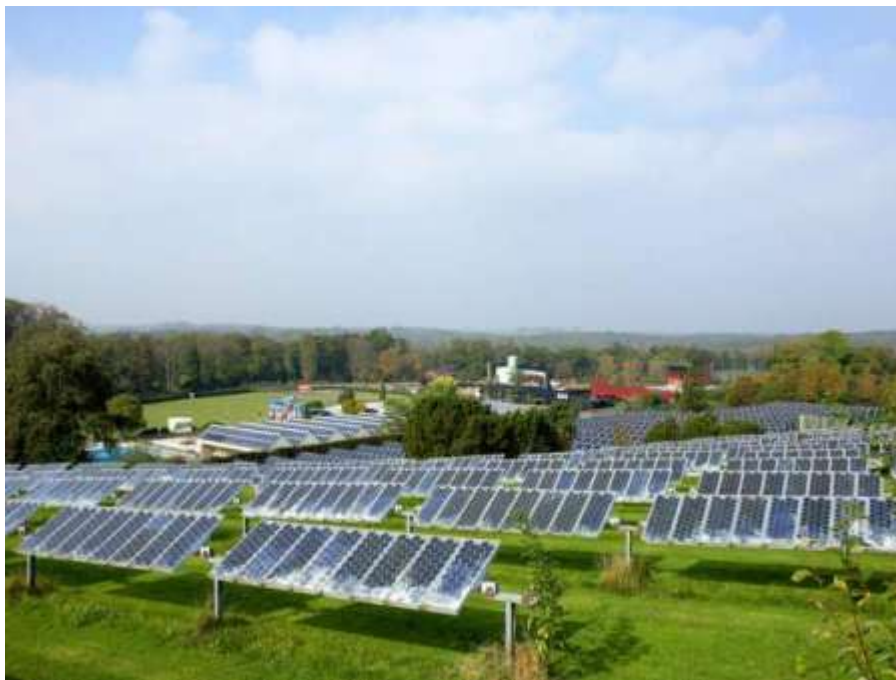
Figura 3.2: L'impianto di Chevetogne quando era ancora in funzione
