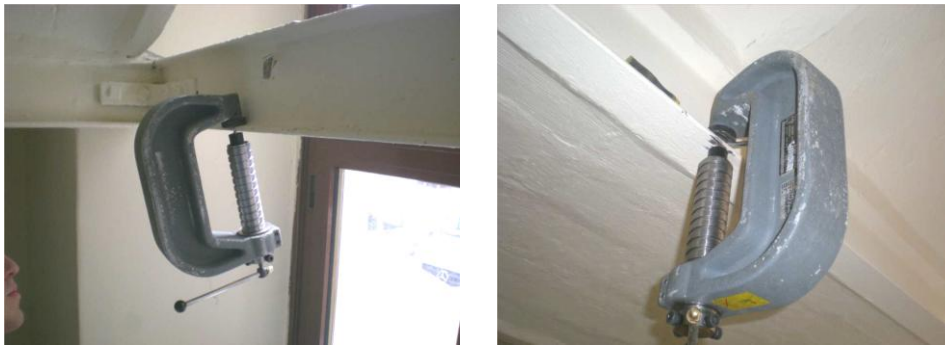
Fig. 4.52: Esecuzione delle prove con il durometro sui profili in acciaio della scala interna
