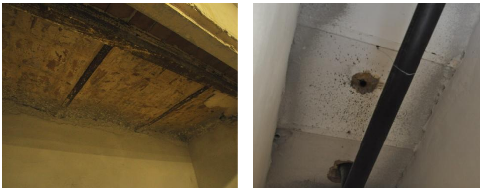
Fig. 4.31: Foto dell'intradosso di SOL1
