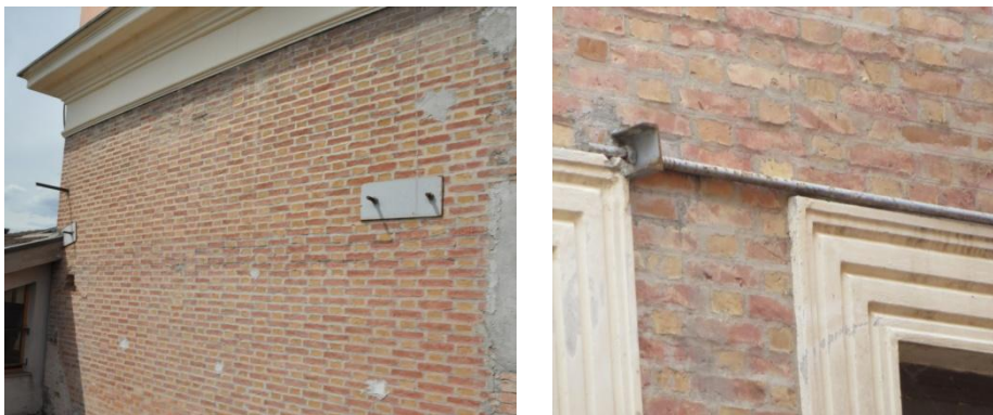
Fig. 4.29: Piastre e tiranti utilizzati per l'ancoraggio delle murature
