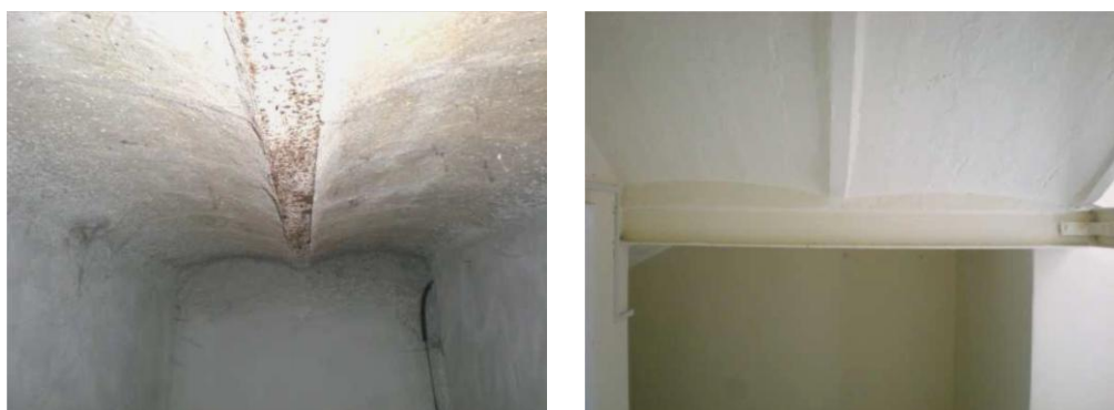
Fig. 4.47: Foto dell'intradosso della scala interna
