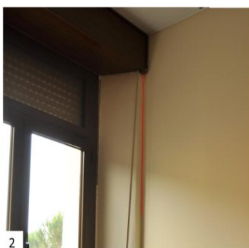
Fig. 4.53: Identificazione del quadro fessurativo
