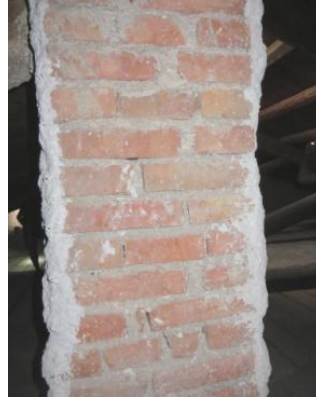
Fig. 4.16: Esempio di MUR2 rilevato nel sottotetto
