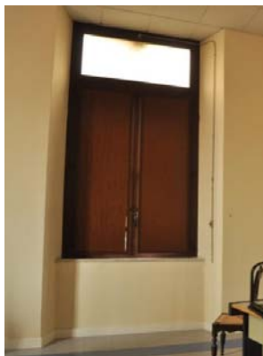
Fig. 4.21: Esempio di sottofinestra con sezione muraria ridotta
