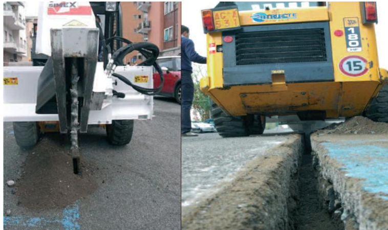
Figura 4.4 taglio della pavimentazione per la posa dei cavi
