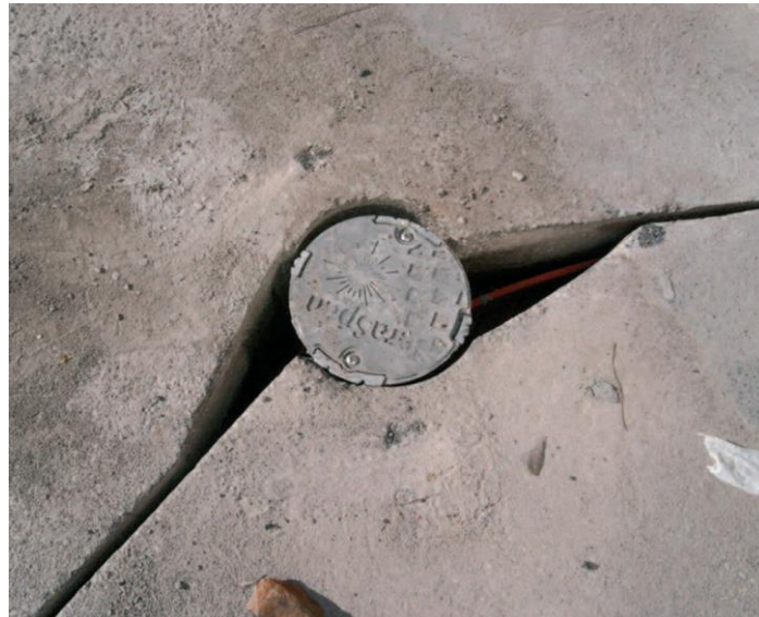
Figura 4.7 elemento di raccordo o diramazione
