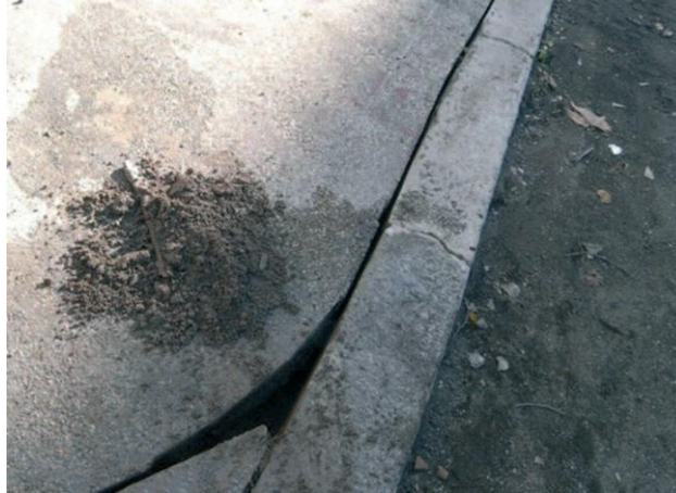
Figura 4.6 realizzazione della microtrincea sul marciapiede
