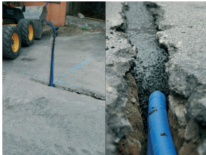
Figura 4.5 posa dei tubi e successivo riempimento della trincea
