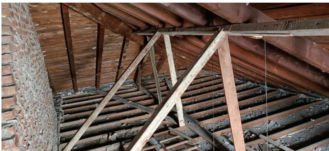
Figura 5.3: Dettaglio interno sottotetto
