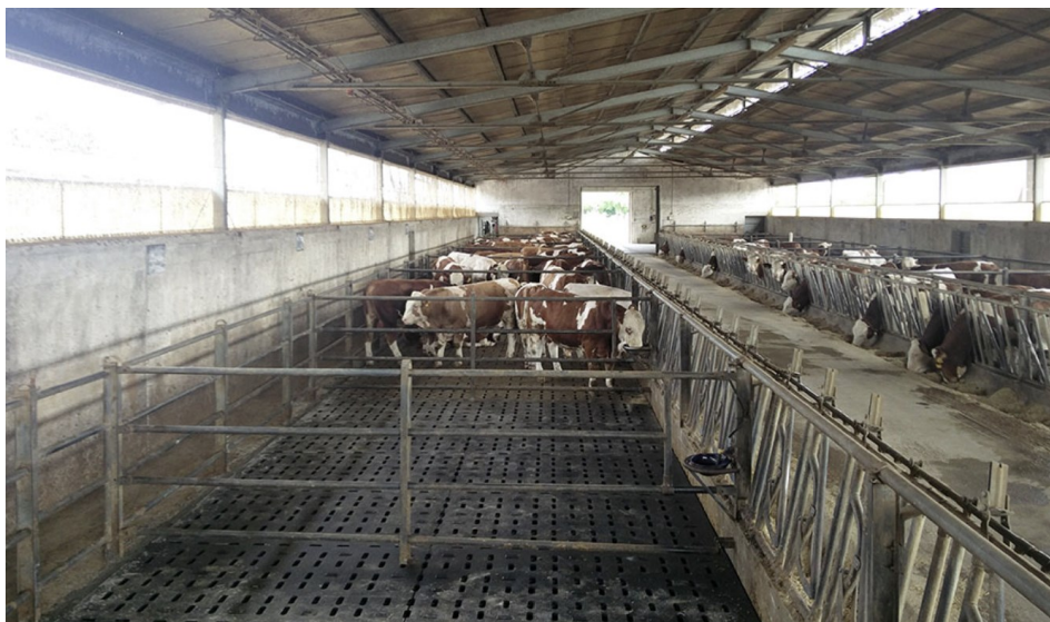
Figura 12. Pavimento fessurato ricoperto da materassino in gomma (Dalla Mora Prefabbricati).
