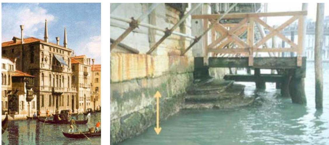
Fig. 13, (A sinistra) dettaglio del quadro di Canaletto, Il Canal Grande dai Palazzi Falier e Giustinian Lolin verso il Palazzo Venier della Torricella , 1735, Londra, Collezione privata. Fig. 14 (A destra) Immagine odierna dell'ingresso del palazzo, risorsa disponibile da Le niveau de la mer à Venise d'après l'œuvre picturale de Véronèse, Canaletto et Bellotto , p. 99 (la freccia indica lo spostamento della fascia di alghe).
