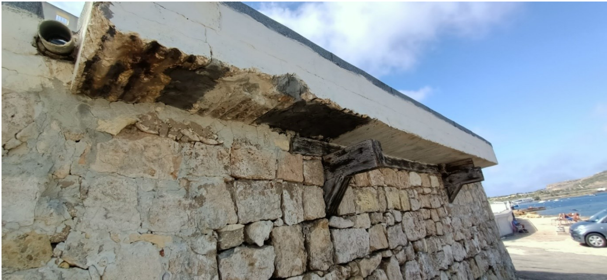
Figura 21 – Particolare di pillbox con lamina ondulata (Foto dell'autore, 2024)
