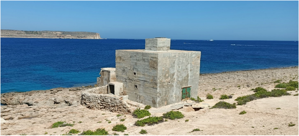
Figura 6 – Pillbox in cemento armato senza pietre (Foto dell'autore, 2024)
