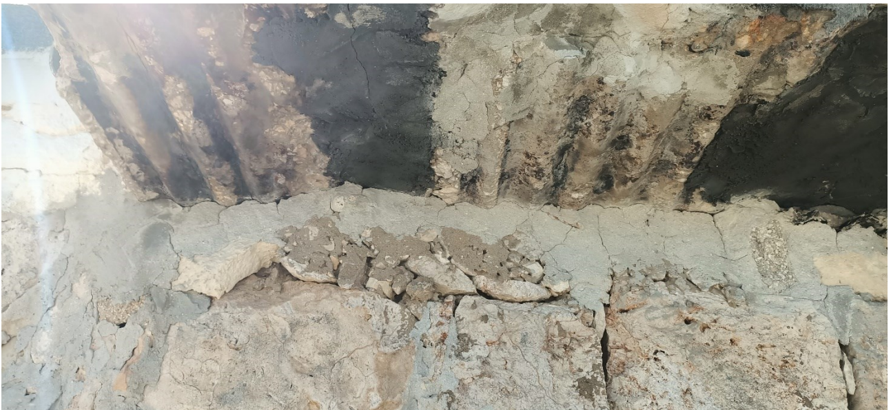
Figura 22 – Particolare di pillbox con lamina ondulata (Foto dell'autore, 2024)
