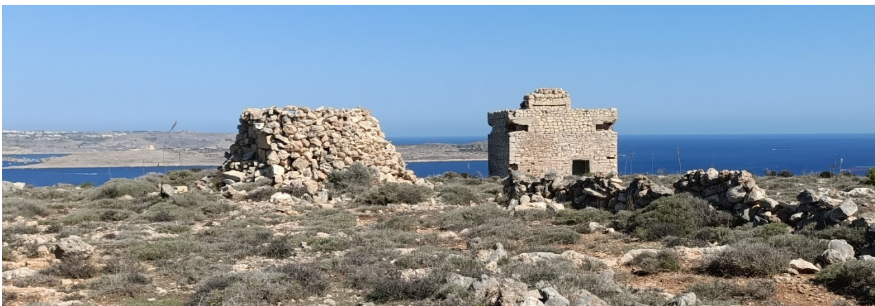
Figura 5 – Edificio rurale sulla sinistra e pillbox ricoperto di pietre sulla destra (Foto dell'autore, 2024)
