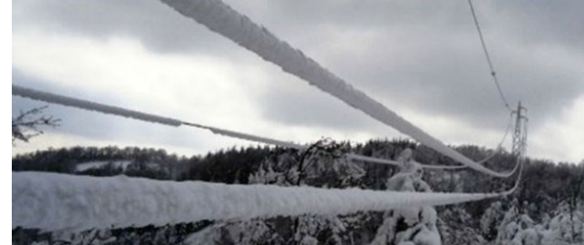
Manicotti di ghiaccio sui conduttori durante il blackout di Cortina nel 2013
