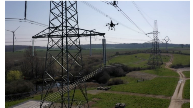
Utilizzo dei droni con sensori di campo elettrico per il monitoraggio di tralicci e isolatori
