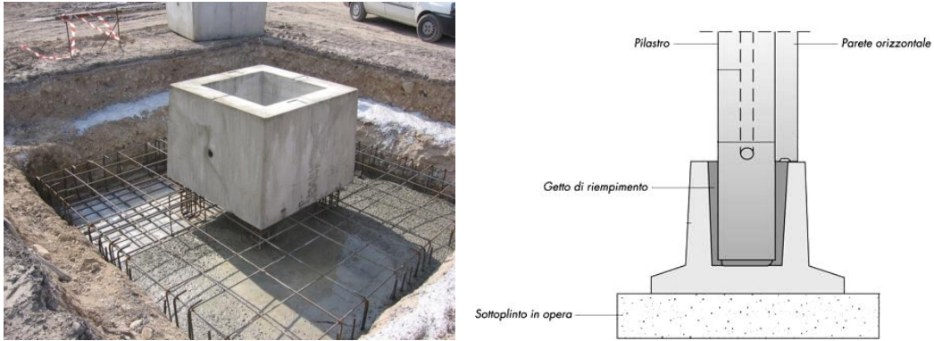
Figura 3.3: Bicchieri prefabbricati per alloggiamento del pilastro
