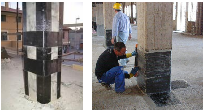
Figura. 3.10: Diverse tipologie di fasciatura dei pilastri con guaine in FRP
