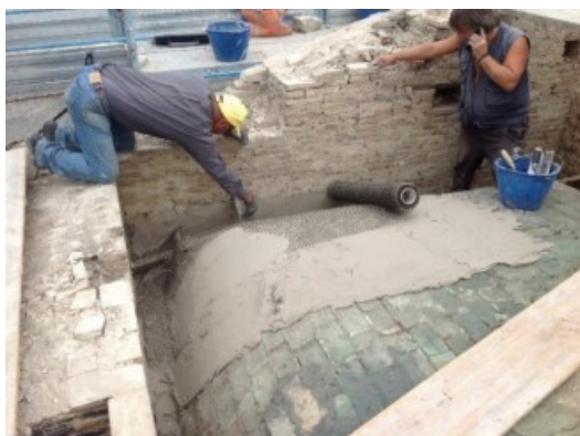
Figura 4.2 – Rinforzo estradossale di una volta
