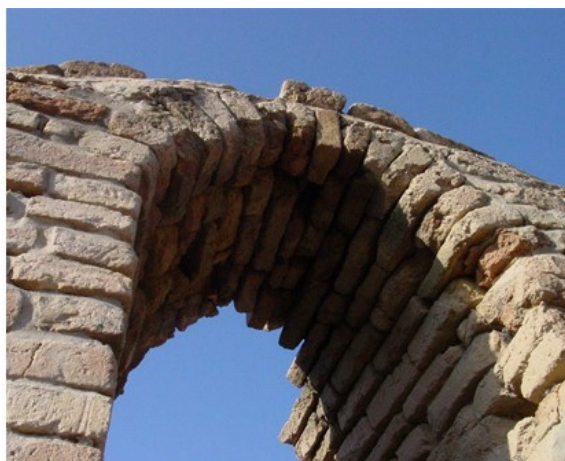
Figura 2.1 – Il più antico arco in muratura presso la Ziqqurat di Ur
