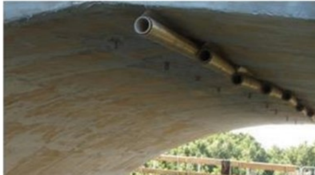
Figura 4.1 – Rinforzo intradossale di un ponte
