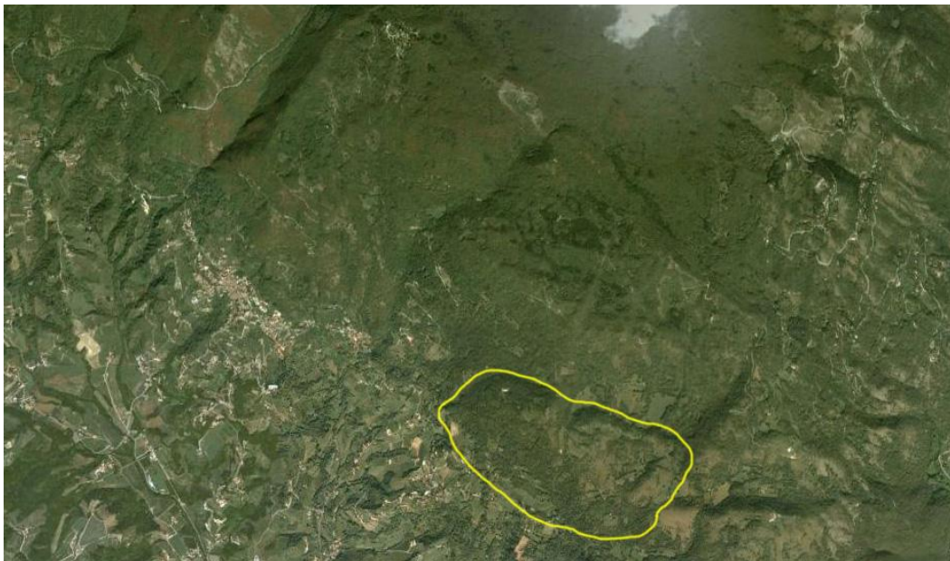
Fig.20: Corpo di frana supposto, corrispondente alla zona 2 (da: Google Earth™, modificata).
