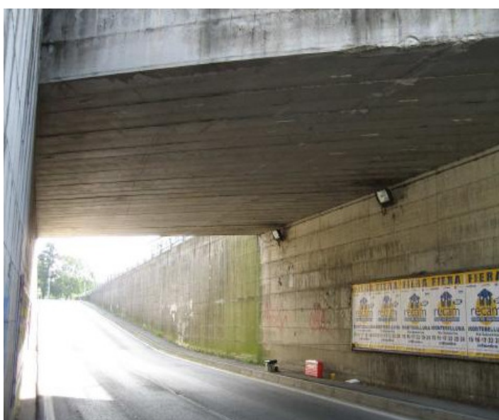
Figura 10.5: "Vista dell'intradosso dell'impalcato"
