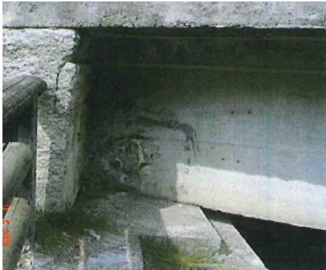
Figura 10.13: "Particolare del giunto di espansione in testa all'impalcato"
