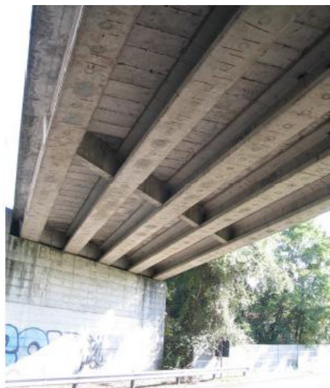
Figura 10.21: “Particolare del graticcio di travi”
