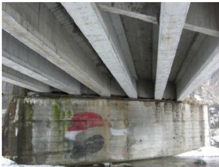
Figura 10.9: "Il graticcio di travi che sorregge la soletta"
