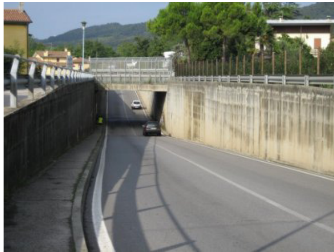
Figura 10.2: "Vista frontale del ponte Via Diaz"
