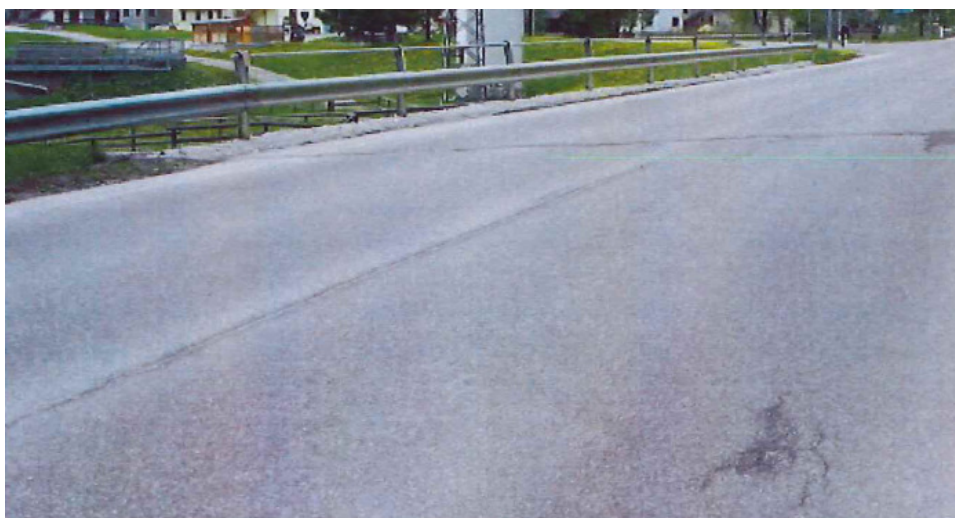
Figura 10.19: “Particolare della pavimentazione stradale”
