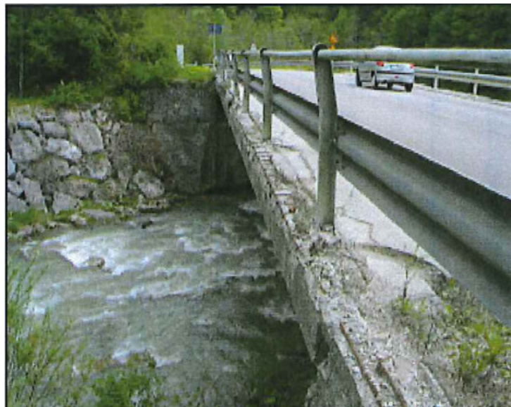
Figura 10.17: "Cordoli esterni e barriere di protezione"
