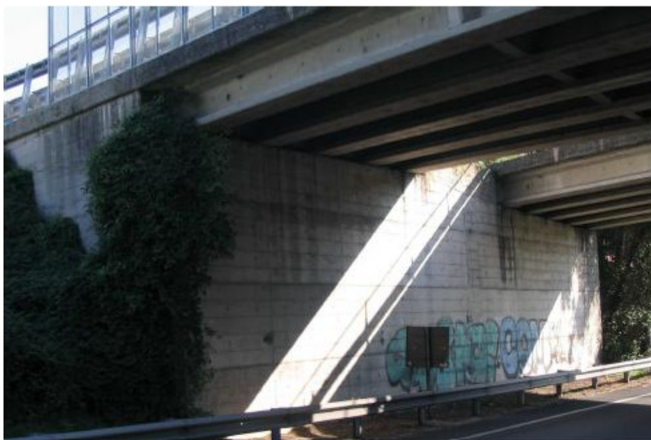
Figura 10.20: “Vista del ponte Cavalcavia S.P. 62”
