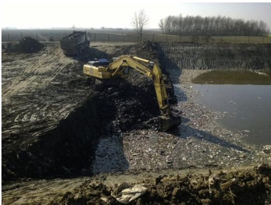
Figura 16: Scavo dei rifiuti senza che sia stata effettuata l'estrazione preliminare del percolato. Figura 17: Scavo dei rifiuti a seguito dell'estrazione preliminare del percolato.
