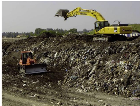
Figura 16: Scavo dei rifiuti senza che sia stata effettuata l'estrazione preliminare del percolato. Figura 17: Scavo dei rifiuti a seguito dell'estrazione preliminare del percolato.
