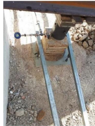
Test n.1- detail of jack and sensor positioning
