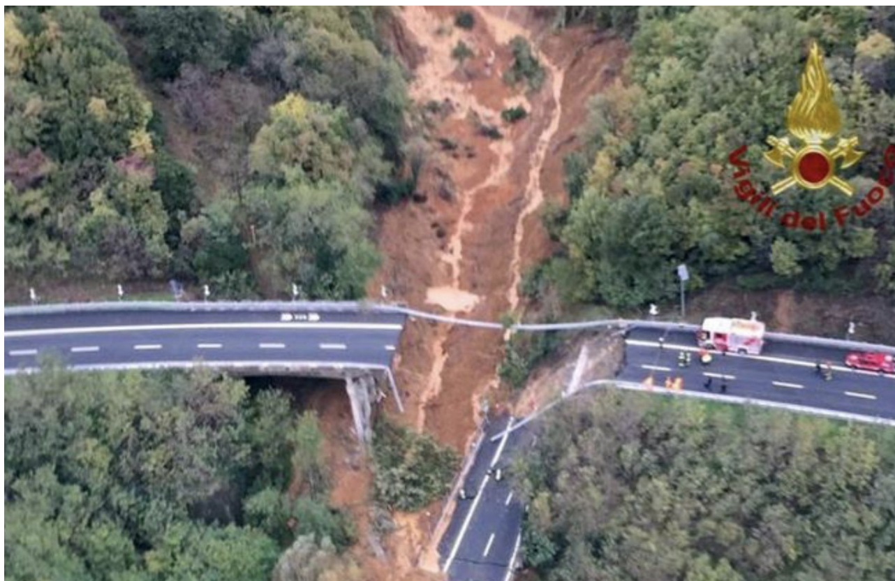
Figura 32 Autostrada A6, soggetta a frana.
