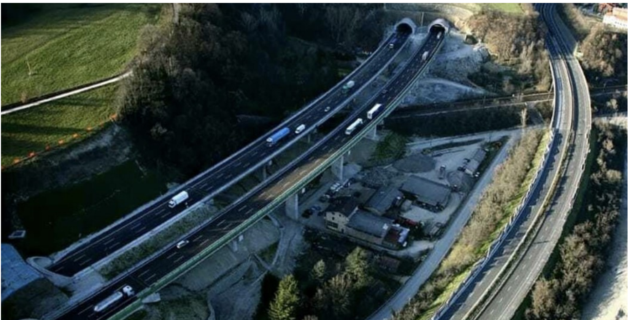
Figura 28 Autostrada del sole (A1), soggetta alla frana.
