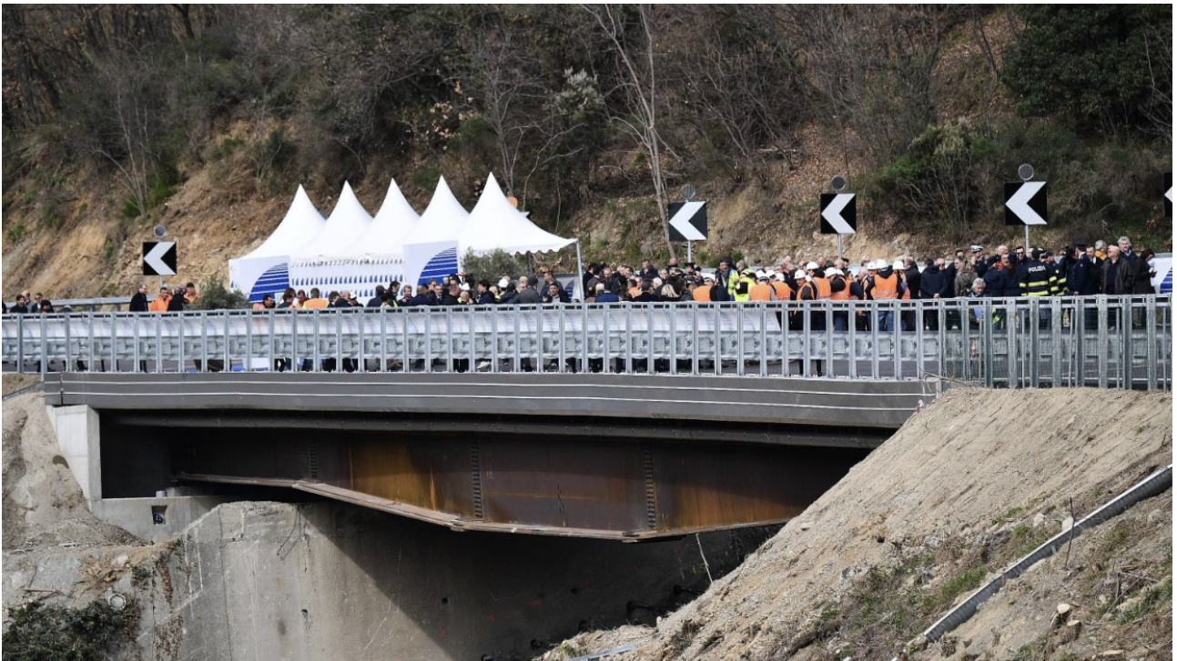
Figura 33 Nuovo viadotto realizzato sull'autostrada.
