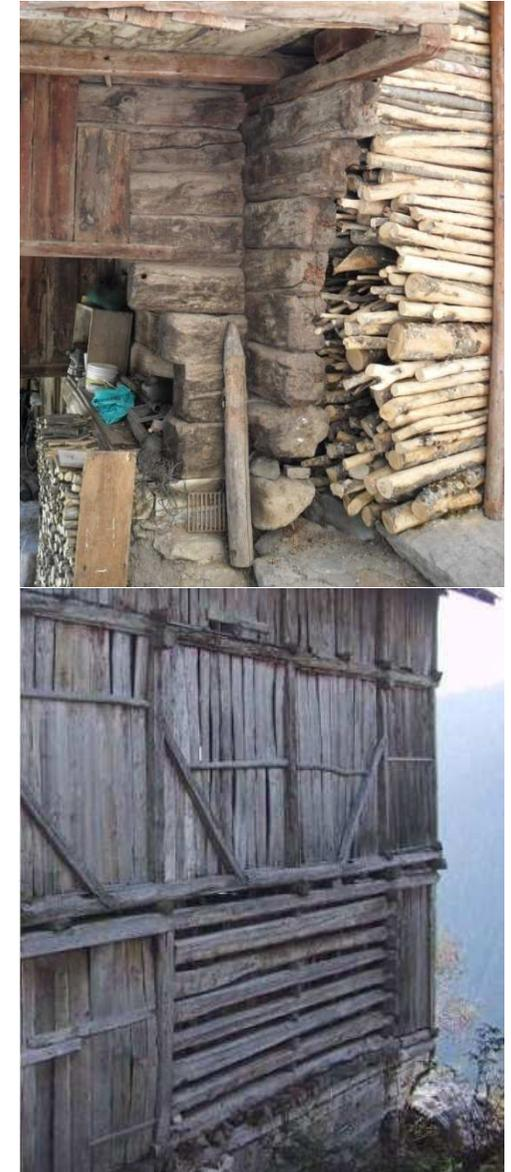
Figura 4.19. Struttura in legno di tipo *blockbau* e di tipo intelaiato
