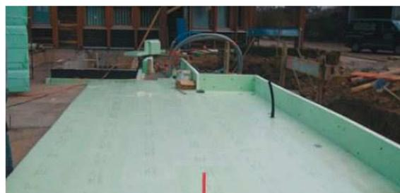
Figura 5.27. Messa in opera di pannelli isolanti Styrodur C sotto la platea di fondazione
