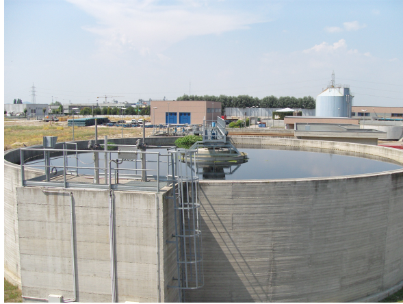
Fig. 3.7: Vasca di chiarificazione.
