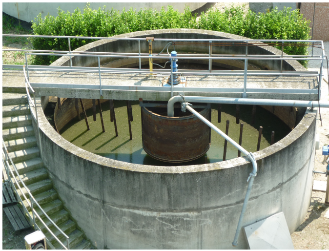
Fig. 3.10: Pre-ispessitore linea fanghi.
