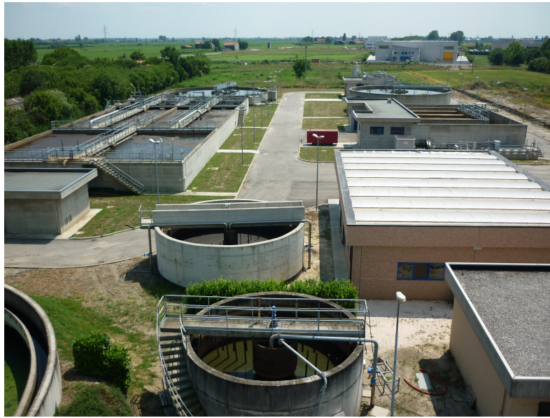
Fig. 3.6: Ossidazione biologica, sedimentazione finale e chimico fisico linea2.
