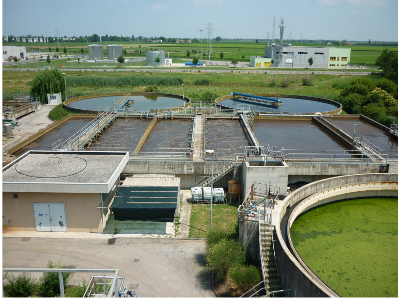
Fig. 3.5: Ossidazione biologica e sedimentazione finale linea1.
