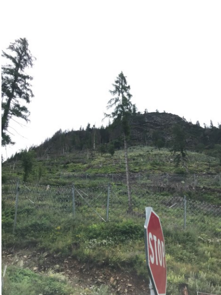
Figura 2.1 Reti paramassi a valle e reti fermaneve a monte di un versante trattato a salvage logging, in seguito alla tempesta Vaia, nel comune di Livinallongo del Col di Lana (BL) - 2023
