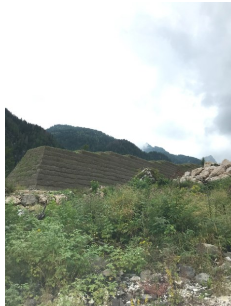
Figura 2.2 Terrapieno in costruzione, in seguito alla tempesta Vaia, nel comune di Rocca Pietore (BL) a protezione delle abitazioni a valle - 2023
