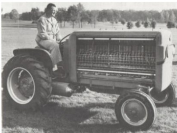
Figura 5: Il trattore a celle a combustibile realizzato da Allis-Chalmers, 1959
