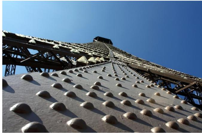
**Figure 1.21.** Rivet à tête sphérique    **Figure 1.22.** Tour Eiffel rivetée ([www.dreamstime.com](http://www.dreamstime.com))
