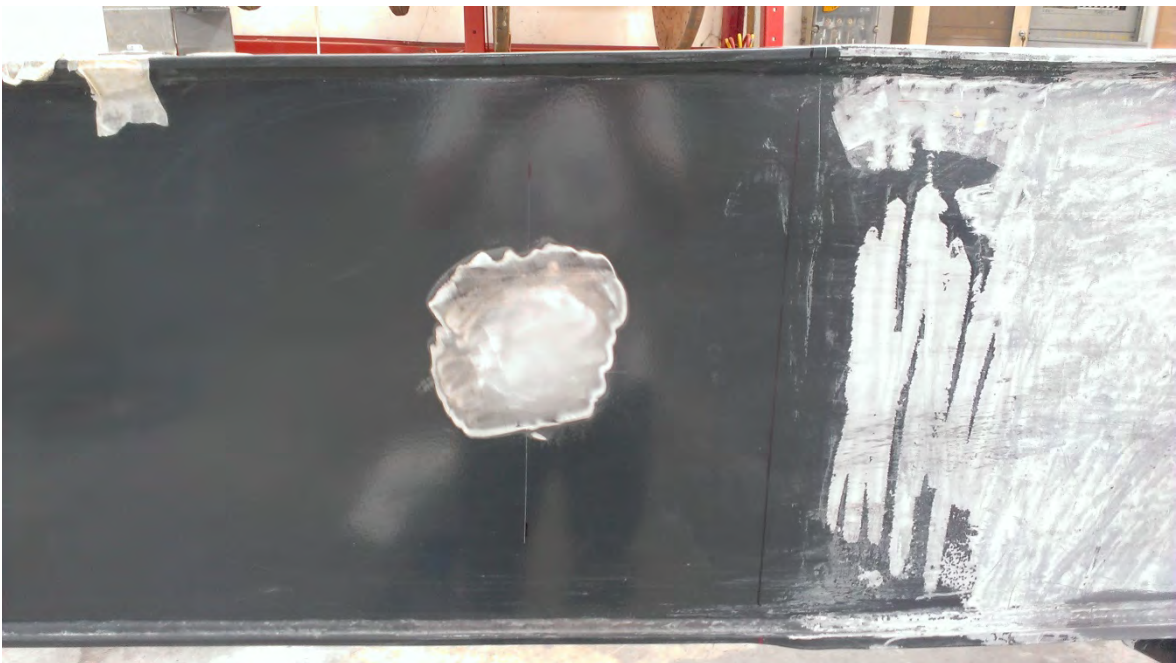
Figura 7.20: Vista della zona di incollaggio per gli estensimetri nel braccio principale della giostra. Si noti sulla destra il primo segno usato come riferimento ed invece centralmente il segno verticale tracciato per posizionare l'estensimetro.
