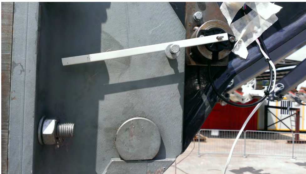
Figura 7.13: Dettaglio posizionamento e fissaggio dell'inclinometro.
