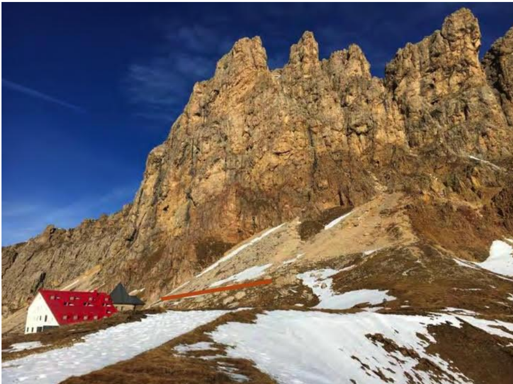
Fig.29- vista da valle del rifugio da proteggere. In arancio la posizione prevista del rilevato paramassi in progetto. In evidenza si notano i due conoidi detritici a monte dell'edificio.
