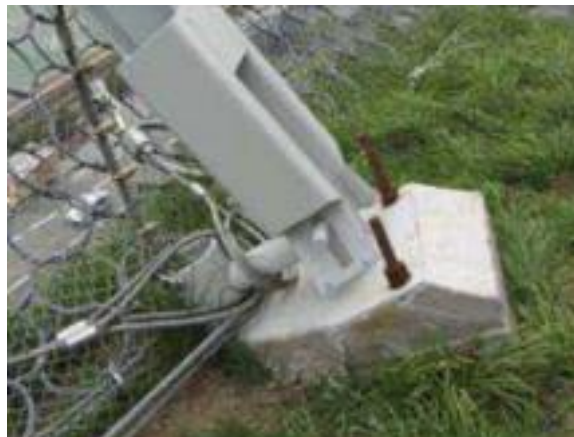
Fig.23 – fondazioni con plinto in calcestruzzo.
