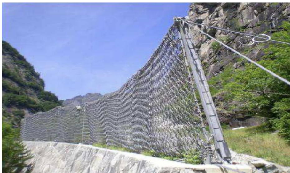
Fig.19 – sopra esempio di barriera paramassi elastica, sotto esempio di barriera paramassi rigida
