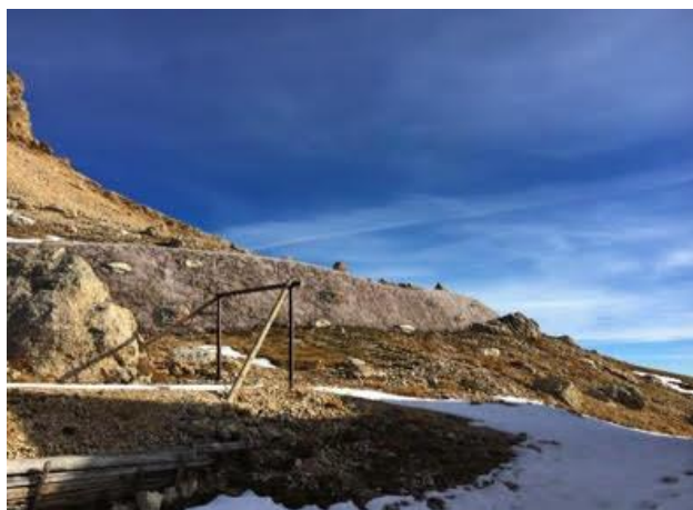
Fig.35 – vista sud-ovest del rilevato paramassi realizzato a ridosso del rifugio
