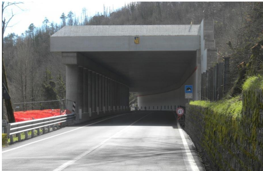
Fig.27– esempio di galleria artificiale.
