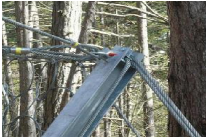
Fig.21 – struttura di supporto: montante a profilo aperto.
