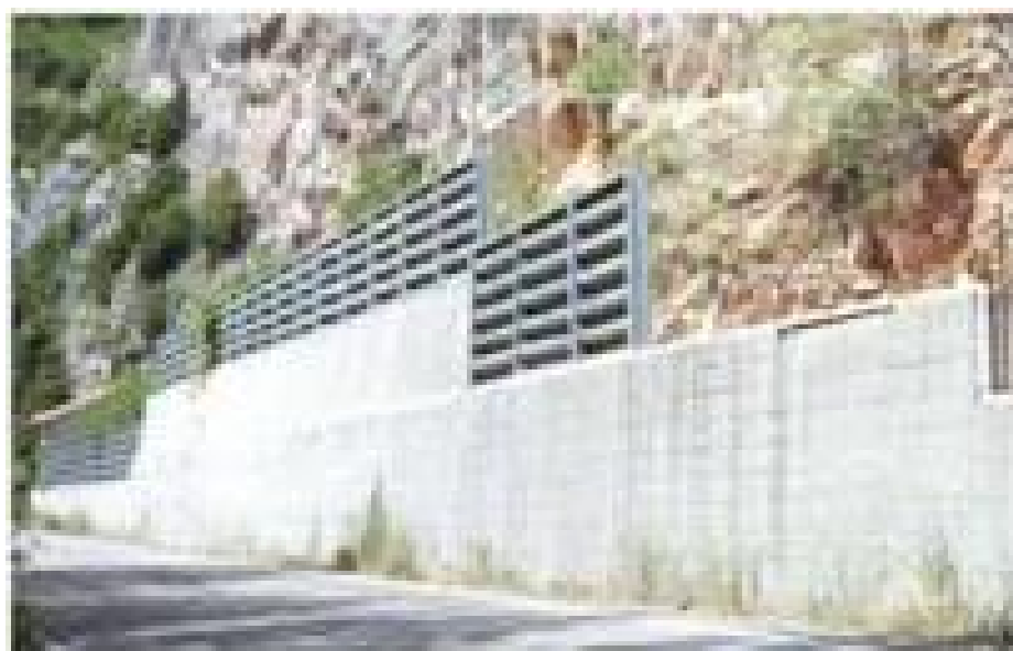
Fig.19 – sopra esempio di barriera paramassi elastica, sotto esempio di barriera paramassi rigida
