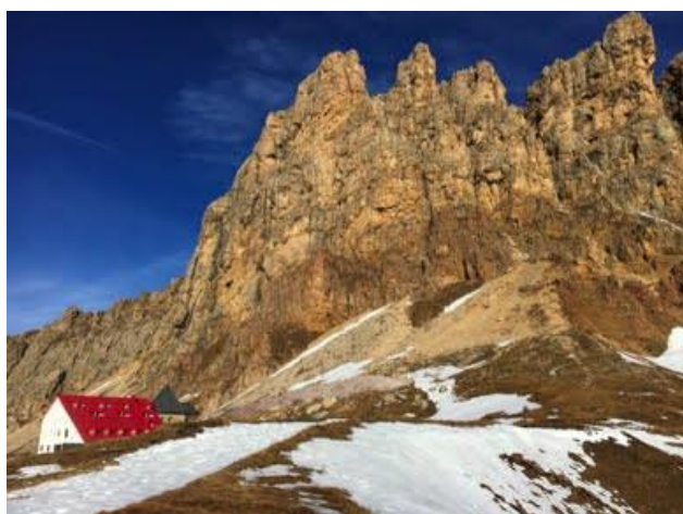
Fig.36 – Vista sud-est del rilevato paramassi per la protezione del rifugio
