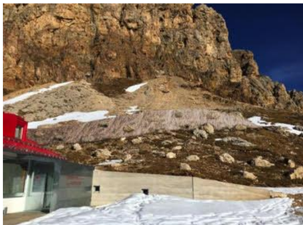
Fig.34 – Vista del rilevato realizzato dalla terrazza del rifugio
