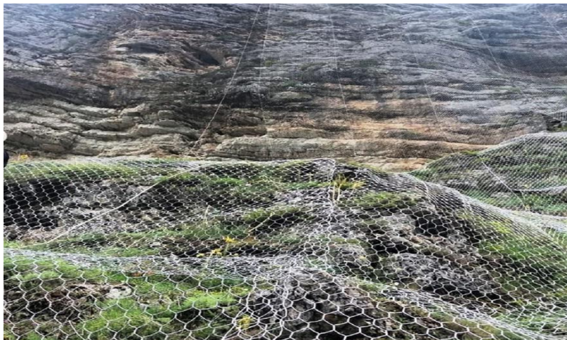
Fig.28 – applicazione di rete paramassi.
