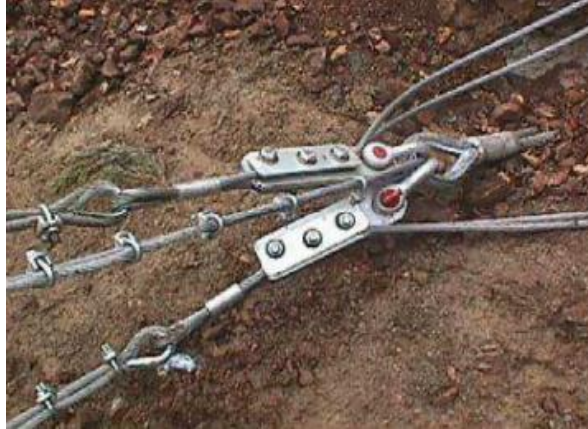
Fig.22 – dissipatore di energia.
